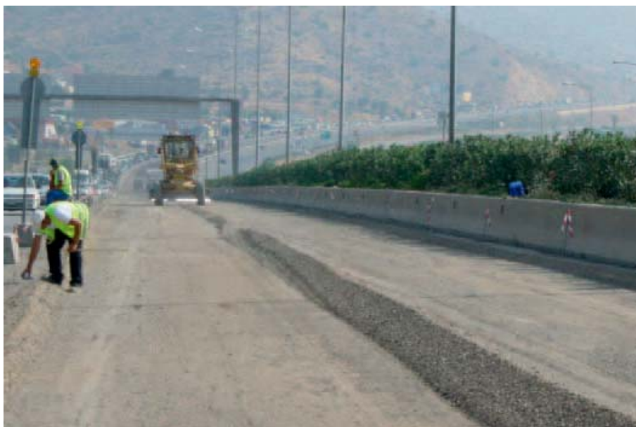
Φωτογραφία 3.8. Διαμόρφωση επιφάνειας πριν την ανακύκλωση
