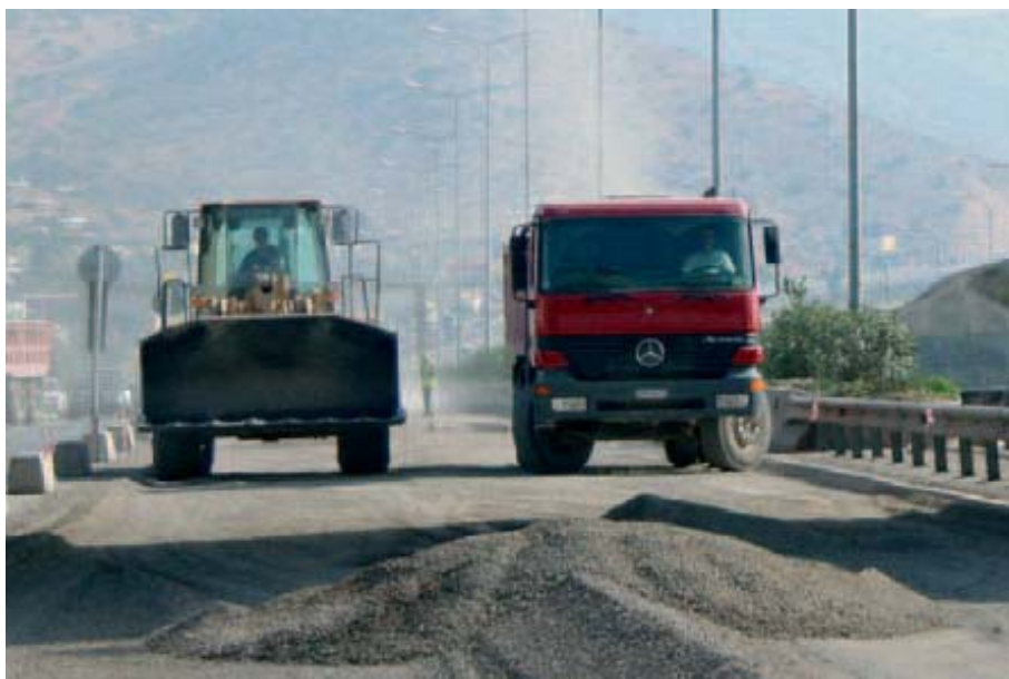
Φωτογραφία 3.7. Απομάκρυνση πλεονάζοντος υλικού
