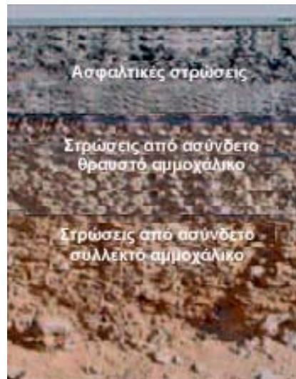
Φωτογραφία 3.3. Τομή στο εύκαμπτο οδόστρωμα πριν την ανακύκλωση
