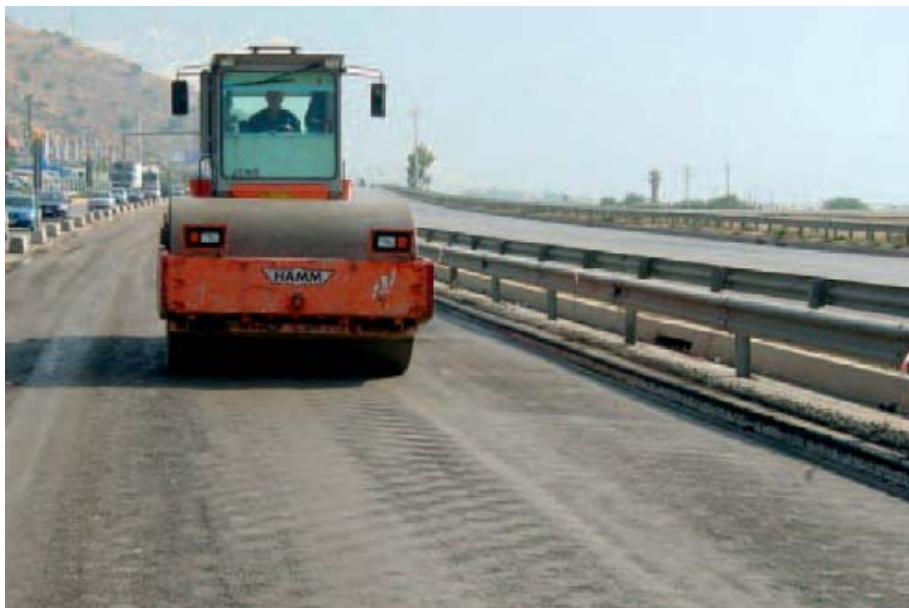
Φωτογραφία 3.13. Τελική συμπύκνωση (περαίωση της επιφάνειας)
