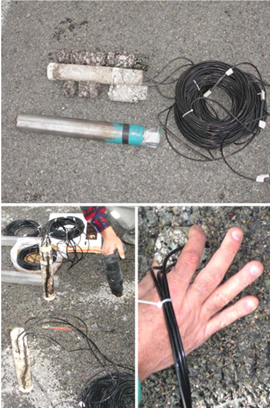
Φωτογραφία 7.2. Τοποθέτηση πυρήνα με σύστημα οπτικών ινών
