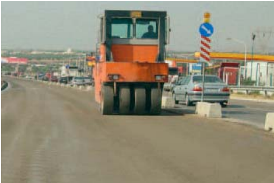
Φωτογραφία 3.12. Συμπύκνωση μετά τη διαμόρφωση
