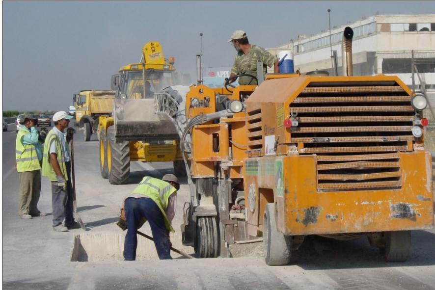
Φωτογραφία 3.4. Ερευνητικές τομές στο οδόστρωμα πριν την ανακύκλωση
