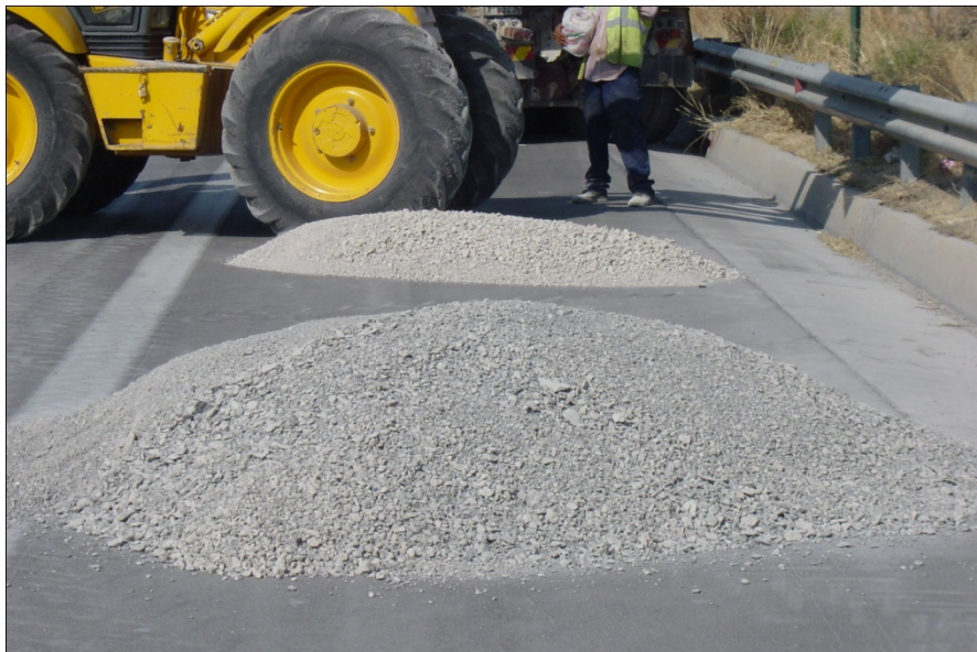
Φωτογραφία 3.5. Υλικό από ερευνητικές τομές στο οδόστρωμα πριν την ανακύκλωση
