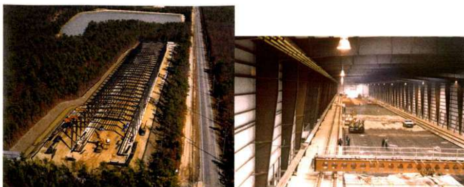
Σχήμα 4.1: Εικόνες από την κατασκευή της εγκατάστασης NAPTF.
