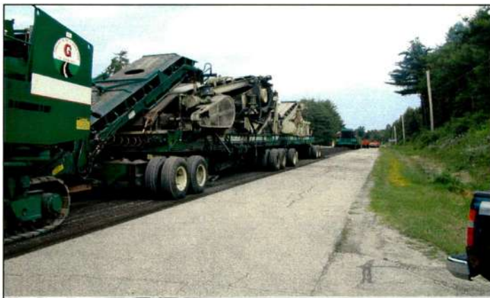
Σχήμα 1.2: Διαδικασία ανακύκλωσης με συρμό μηχανημάτων.
