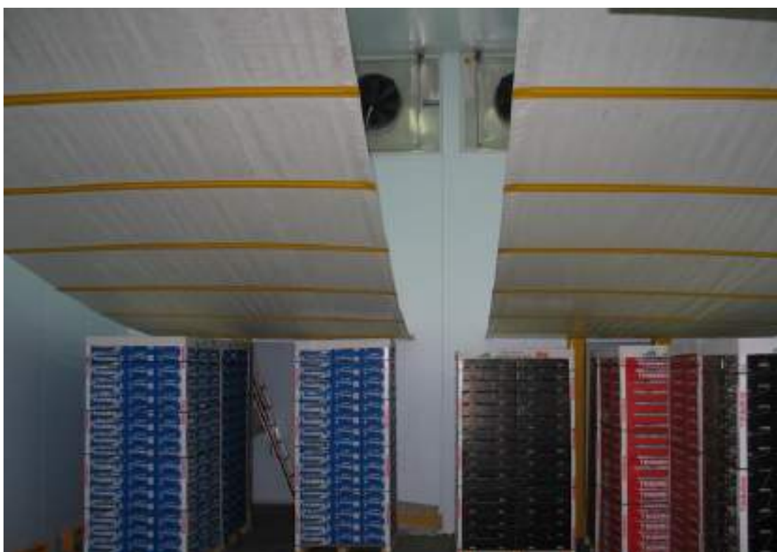
Εικόνα 60 Θάλαμος πρόψυξης (Πηγή; ALFA COOL HELLAS)
