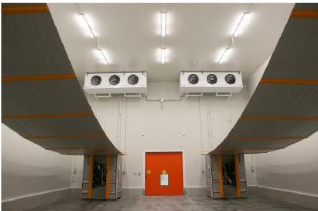
Εικόνα 59 Πρόψυξη με αέρα (πηγή: ALFA COOL HELLAS)
