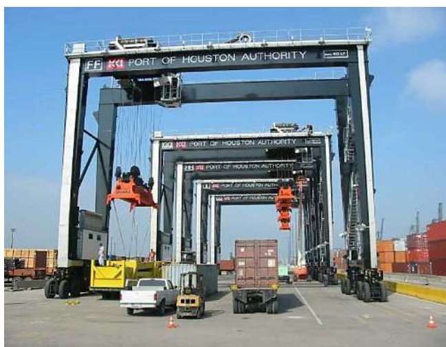
Εικόνα 1. 13: Γερανογέφυρες επί ελαστικών τροχών. Πηγή: [7]
