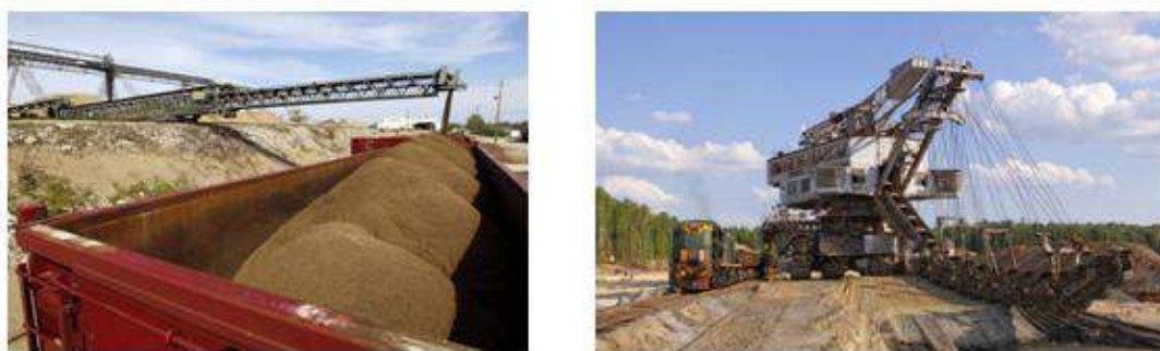
Εικόνα 69: Φόρτωση βαγονιών από γερανό με ταινία μεταφοράς
