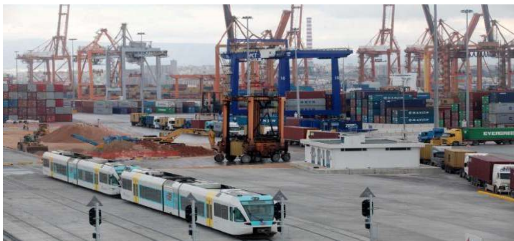
Εικόνα 71: Σιδηροδρομικές εγκαταστάσεις σταθμού Ικονίου (γραμμή προς Θριάσιο) [104]
