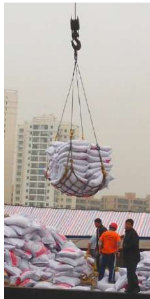
Εικόνα 68: Φόρτωση σάκων από γερανό με γάντζο [103]
