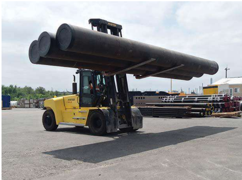
Εικόνα 63: Μεταφορά σωλήνων από περνοφόρο πλάγιας φόρτωσης [99]
