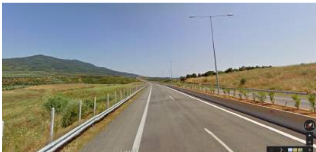
Εικόνα 36. Όψη του υπό εξέταση οδικού τμήματος
