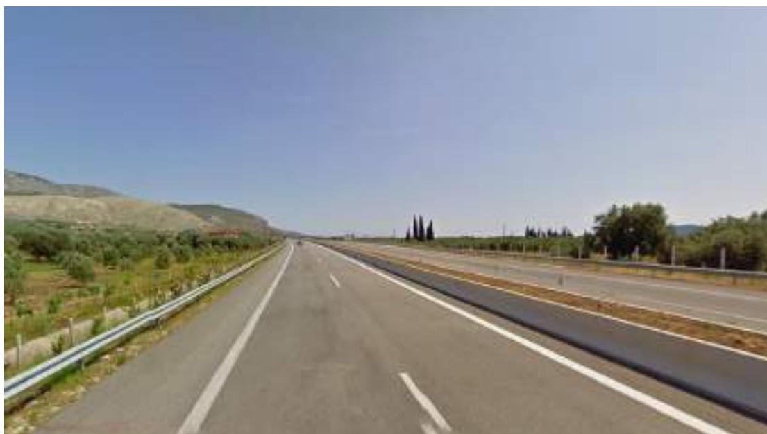
Εικόνα 9. Άποψη του οδικού τμήματος 1 στη Χ.Θ. = 2 + 270
