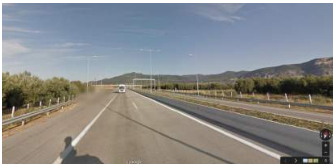
Εικόνα 30. Όψη του υπό εξέταση οδικού τμήματος
