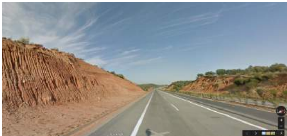
Εικόνα 34. Όψη του υπό εξέταση οδικού τμήματος
