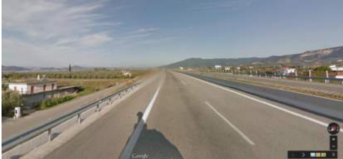
Εικόνα 28. Όψη του υπό εξέταση οδικού τμήματος
