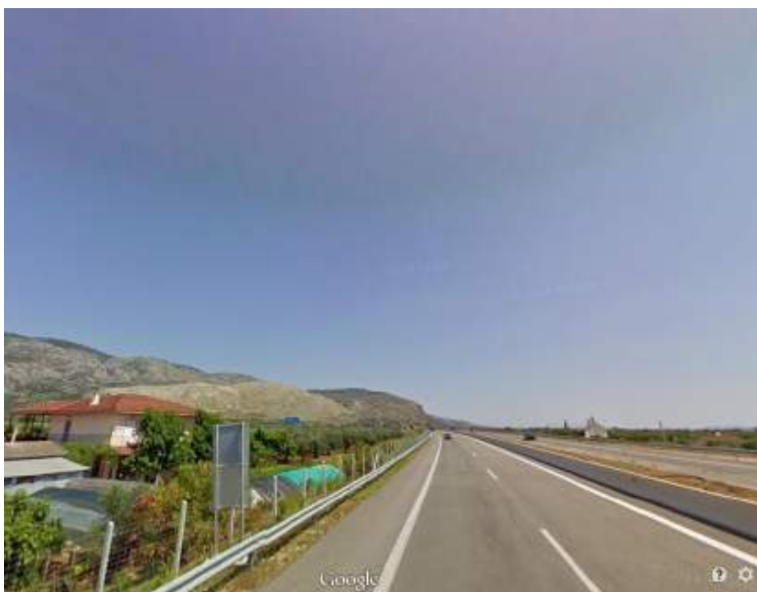
Εικόνα 10. Άποψη του οδικού τμήματος 1 στη Χ.Θ. = 2 + 320
