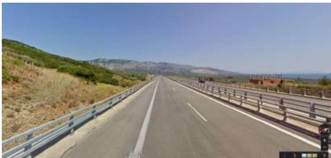
Εικόνα 32. Όψη του υπό εξέταση οδικού τμήματος
