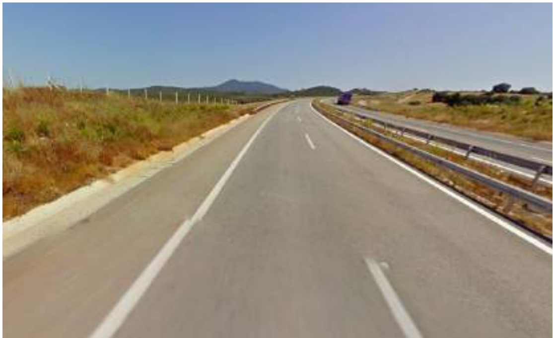
Εικόνα 25. Άποψη του οδικού τμήματος 4 στη Χ.Θ. = 9 + 470
