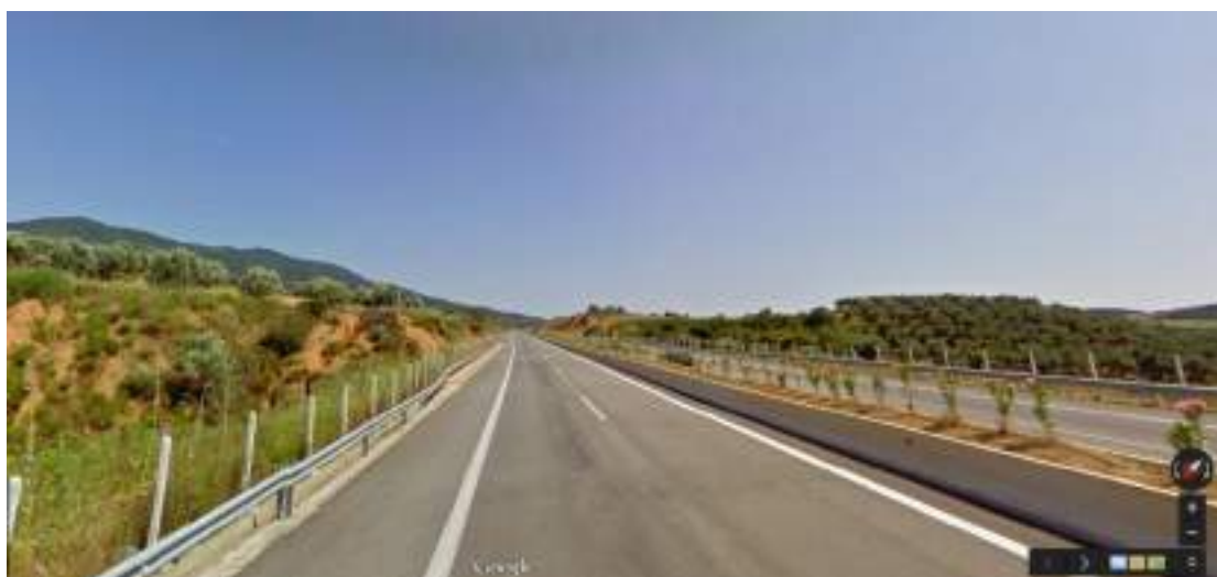
Εικόνα 35. Όψη του υπό εξέταση οδικού τμήματος
