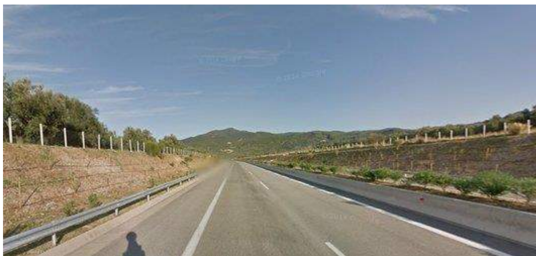
Εικόνα 14. Άποψη του οδικού τμήματος 2 στη Χ.Θ. = 4 + 770
