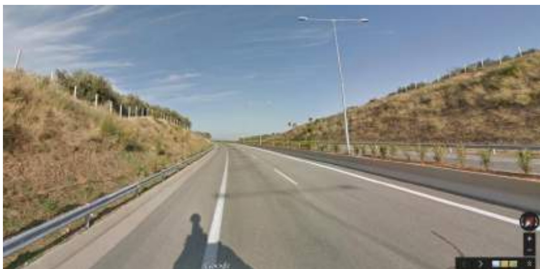
Εικόνα 33. Όψη του υπό εξέταση οδικού τμήματος
