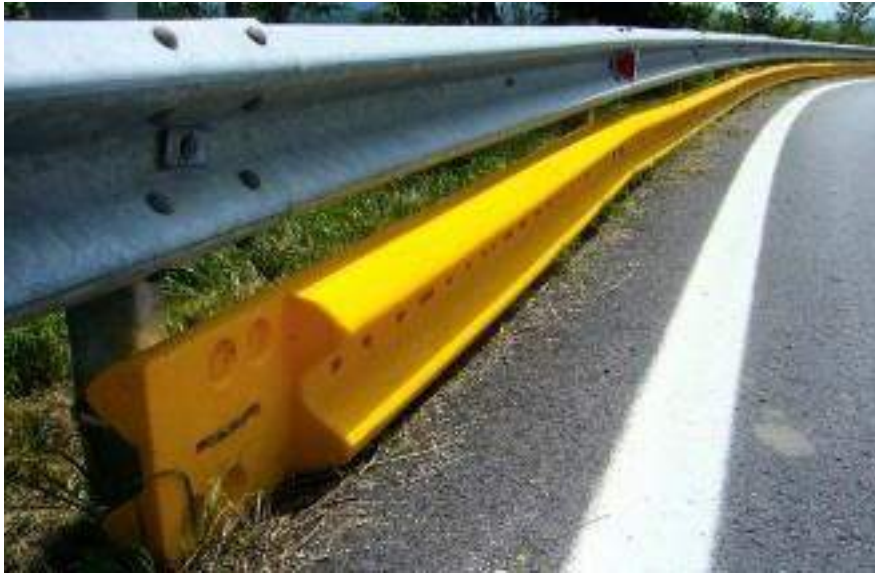
Εικόνα 38. Μεταλλικό στηθαίο ασφαλείας με οριζόντιο έλασμα
