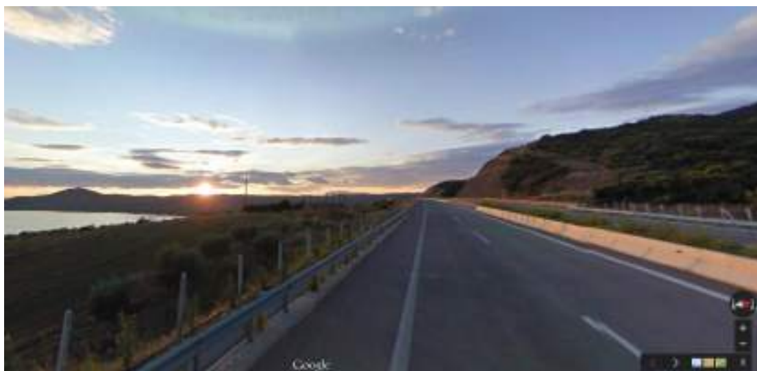
Εικόνα 31. Όψη του υπό εξέταση οδικού τμήματος
