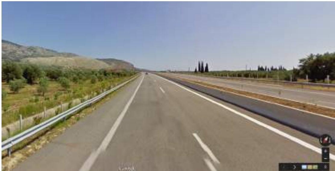
Εικόνα 29. Όψη του υπό εξέταση οδικού τμήματος
