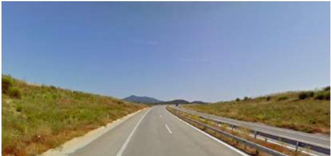
Εικόνα 24. Άποψη του οδικού τμήματος 4 στη Χ.Θ. = 9 + 420
