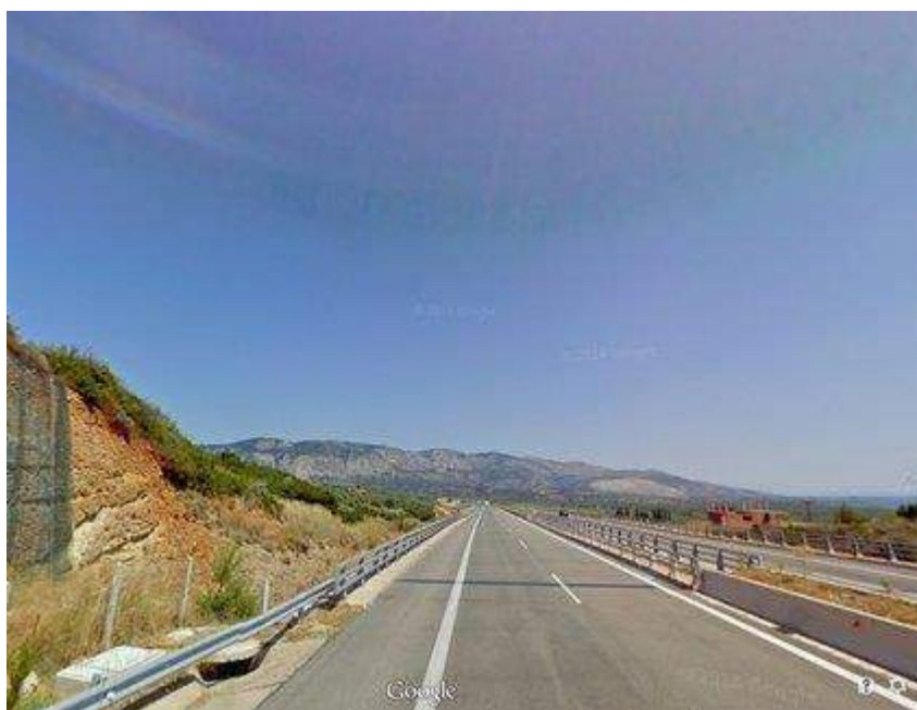
Εικόνα 15. Άποψη του οδικού τμήματος 2 στη Χ.Θ. = 4 + 820
