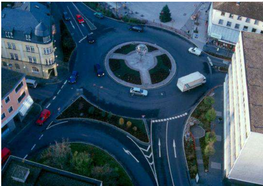
Εικόνα 3.10 Αστικός Μικρός Κυκλικός Κόμβος Δύο Λωρίδων στη Γερμανία. Απουσία διαγράμμισης και αποκλειστικά μία λωρίδα εξόδου (Brilon, 2005).
