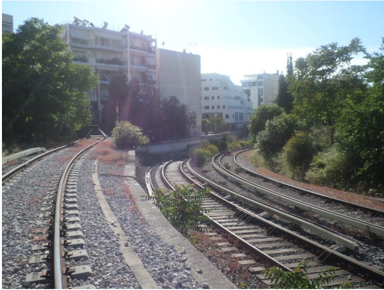
Εικόνα 5.2: Τμήμα γραμμής στο αμαξοστάσιο Σεπολίων
