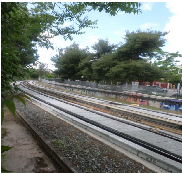
Εικόνα 2.9: Φωτογραφία τμήματος του δικτύου του Η.Σ.Α.Π. στη Χ.Θ. 18+300. Διακρίνονται οι ηχοαπορροφητικές πλάκες στις γραμμές ανόδου και καθόδου
