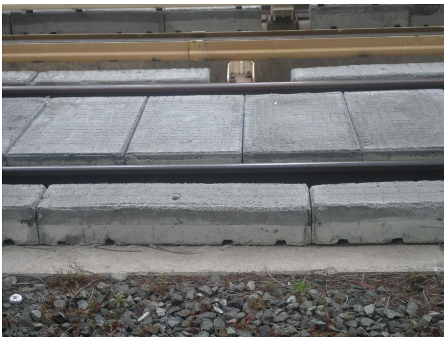
Εικόνα 2.10: Ηχοαπορροφητικές πλάκες στο δίκτυο του Η.Σ.Α.Π. στη Χ.Θ. 18+300. Διακρίνονται τα κεντρικά και πλευρικά πάνελ.
