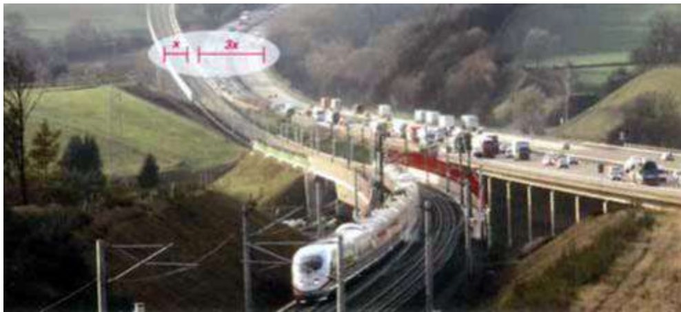
Εικόνα 2: Εύρος κατάληψης διπλής σιδηροδρομικής γραμμής και αυτοκινητόδρομου [6]
