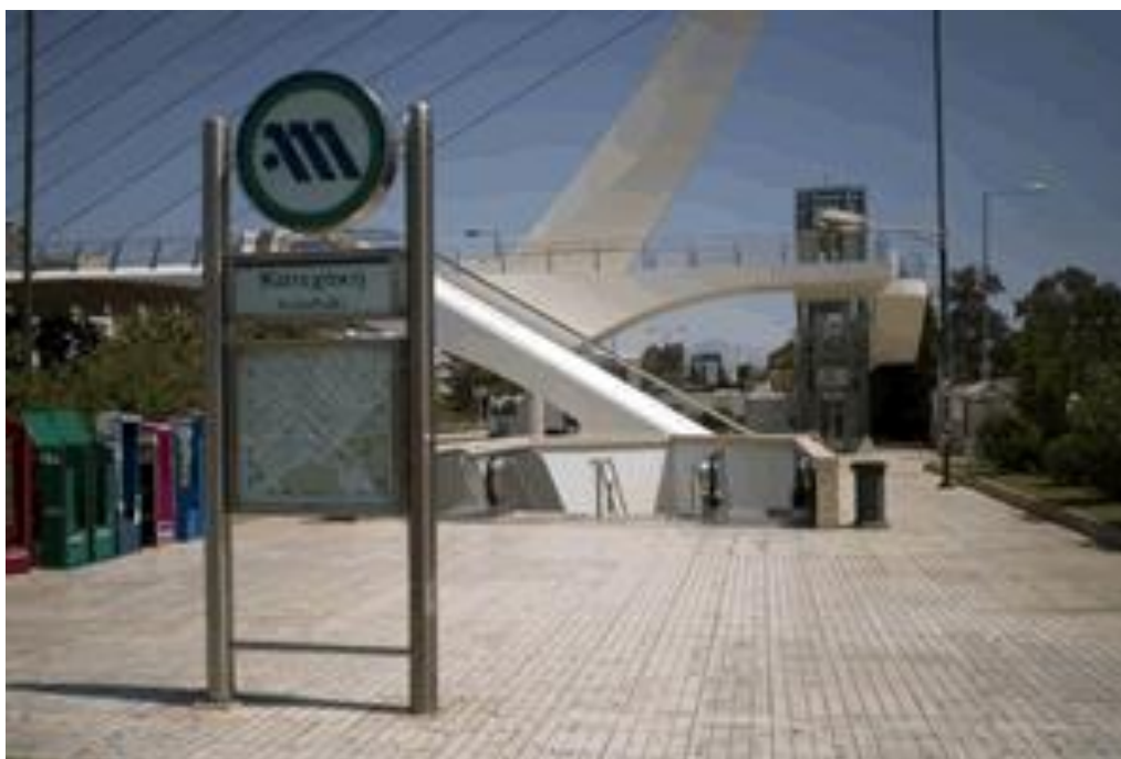
Εικόνα 18: Είσοδος-Εξόδος μετρό Κατεχάκη
