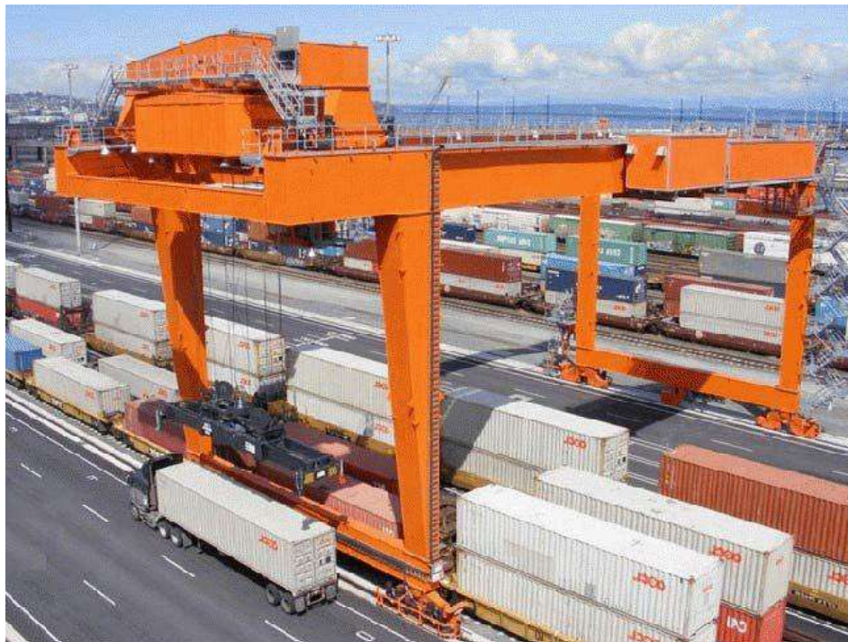
Εικόνα 3: Γερανογέφυρα σε σιδηροτροχιές
