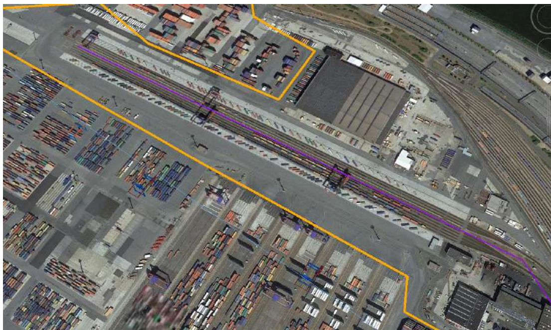
Εικόνα 33: Βόρεια σύνδεση με σιδηρόδρομο
