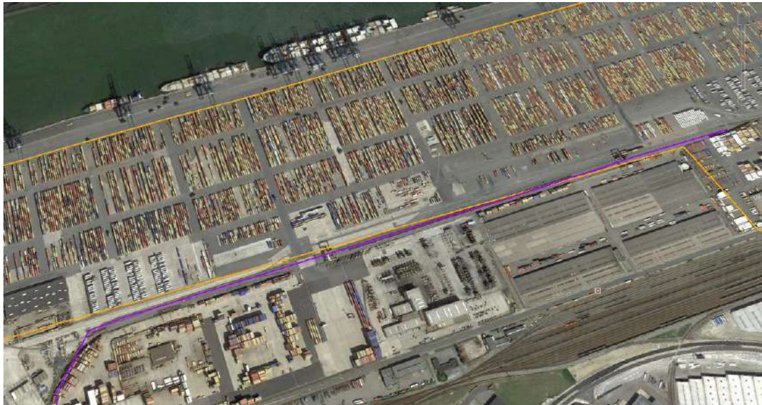
Εικόνα 29: Βόρεια σύνδεση με σιδηρόδρομο
