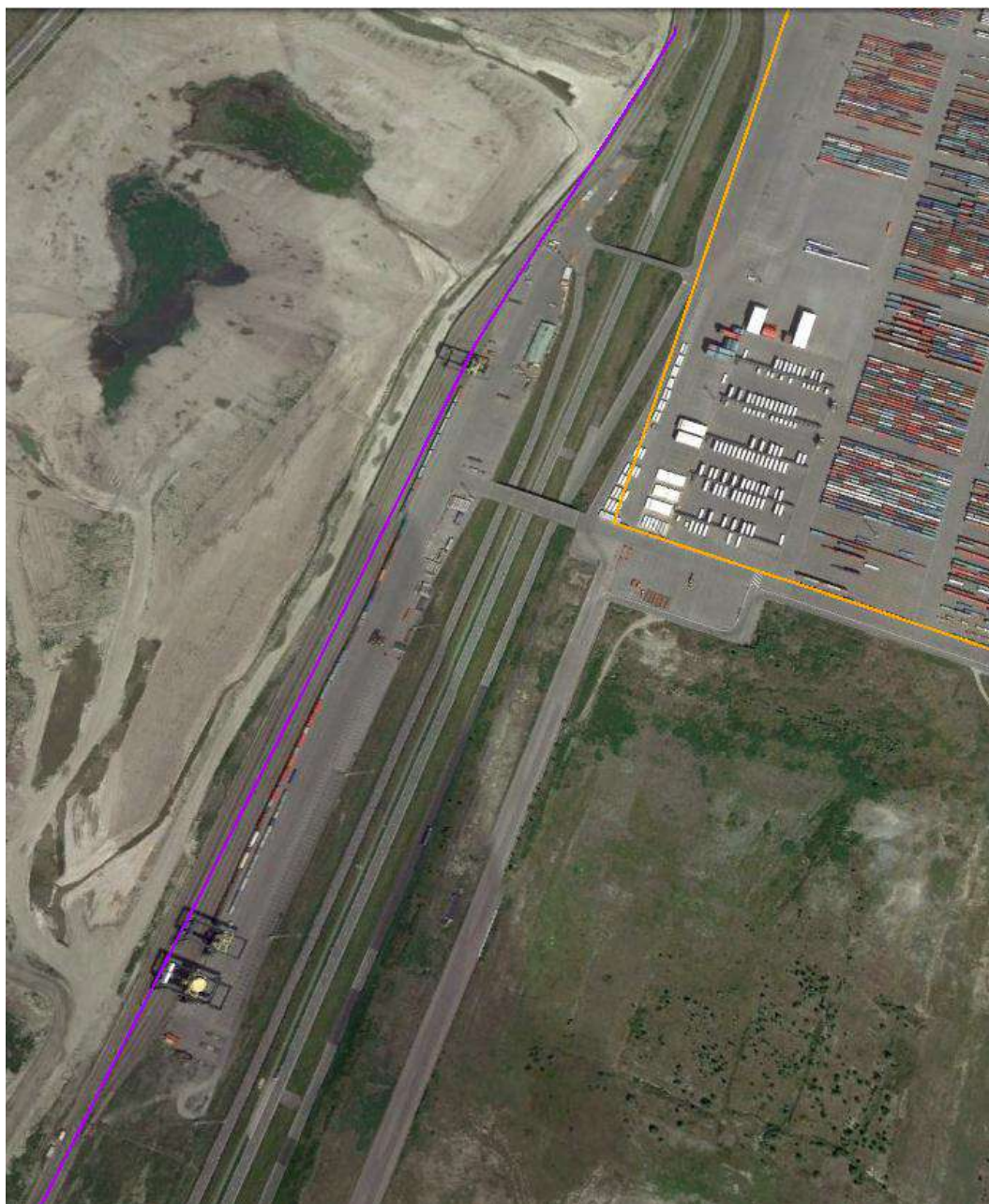
Εικόνα 27: Νοτιοδυτική σιδηροδρομική εγκατάσταση και οι γερανογέφυρες
