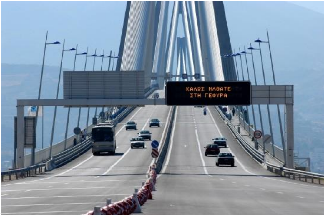
Εικόνα 1, Άποψη της Γέφυρας Ρίου-Αντιρρίου ( www.gefyra.gr )
