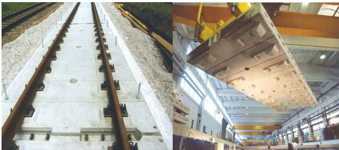
Εικόνα 2.5 Σύστημα σταθερής επιδομής BogI. [1]
