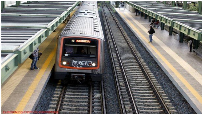
Εικόνα 3.4 Ο ηλεκτρικός σιδηρόδρομος σε τμήμα με σκυρογραμμή.
