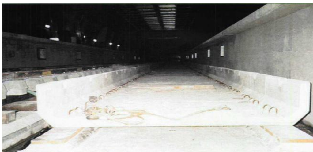
Εικόνα 4.6 Πλωτή πλάκα με συνεχείς λωρίδες ελαστομερών.
