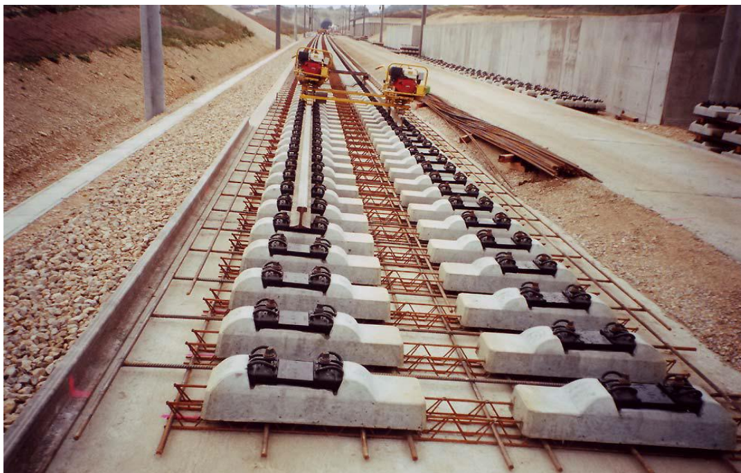
Εικόνα 3.2 Διμερείς στρωτήρες B355.
