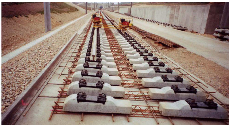
Εικόνα 2.2 Σύστημα σταθερής επιδομής RHEDA 2000.
