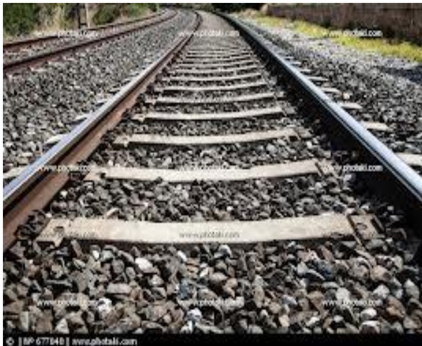
Εικόνα 2.1 Επιδομή με έρμα.
