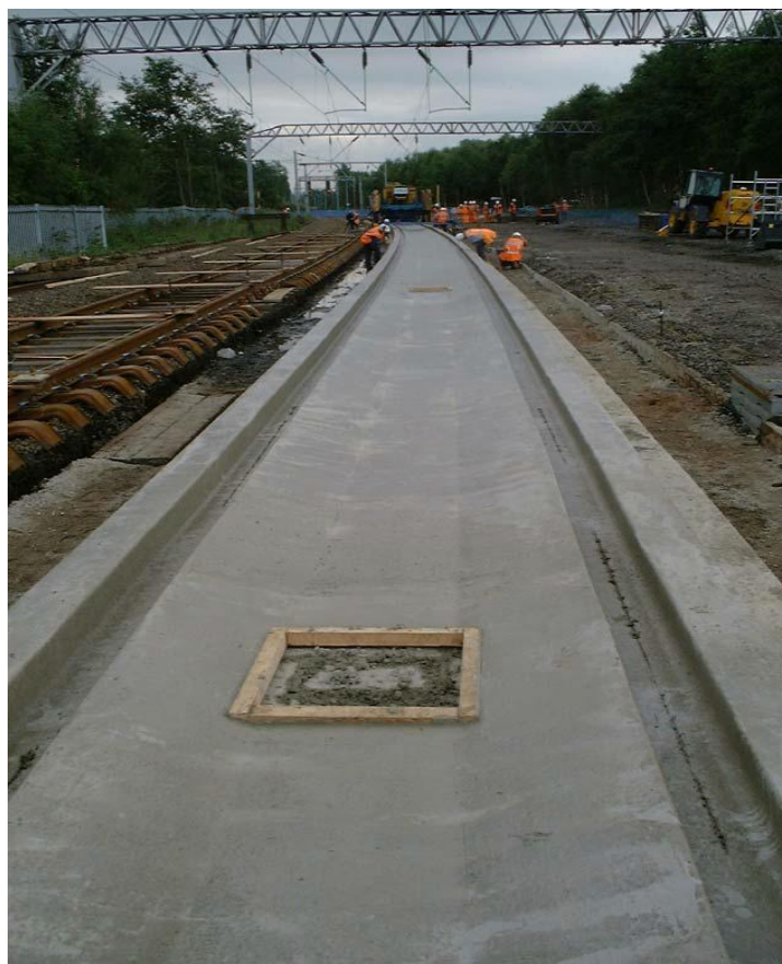
Εικόνα 2.6 Σύστημα σταθερής επιδομής με ενσωματωμένες σιδηροτροχιές.
