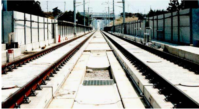
Εικόνα 2.4 Σύστημα σταθερής επιδομής Shinkansen.
