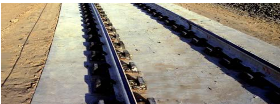
Εικόνα 2.3 Σύστημα σταθερής επιδομής με απευθείας στερέωση.
