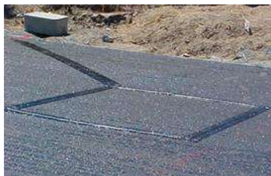
Εικόνες 4.10 και 4.11: Απλός επαγωγικός βρόχος σε σχεδιαστική απεικόνιση (αριστερά) και μετά την εγκατάσταση (δεξιά)
