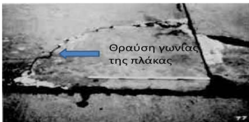
Σχήμα 7.17: Αποτελέσματα φόρτισης στα άκρα της πλάκας σκυροδέματος
