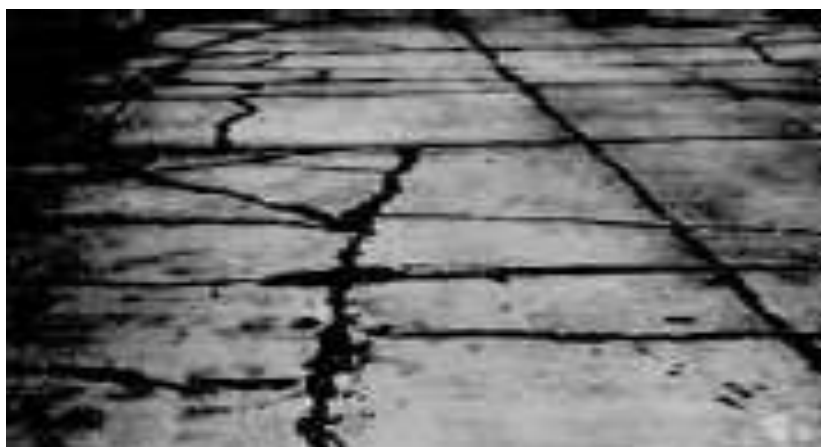
Σχήμα 7.19: Ενδεικτική κατάσταση πλάκας σκυροδέματος (εκτεταμένη διάρκεια ζωής)
