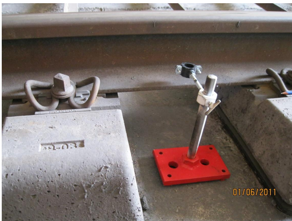
Εικόνα 4.10: Κατασκευή τοποθέτησης μηχανοσκοπίου
