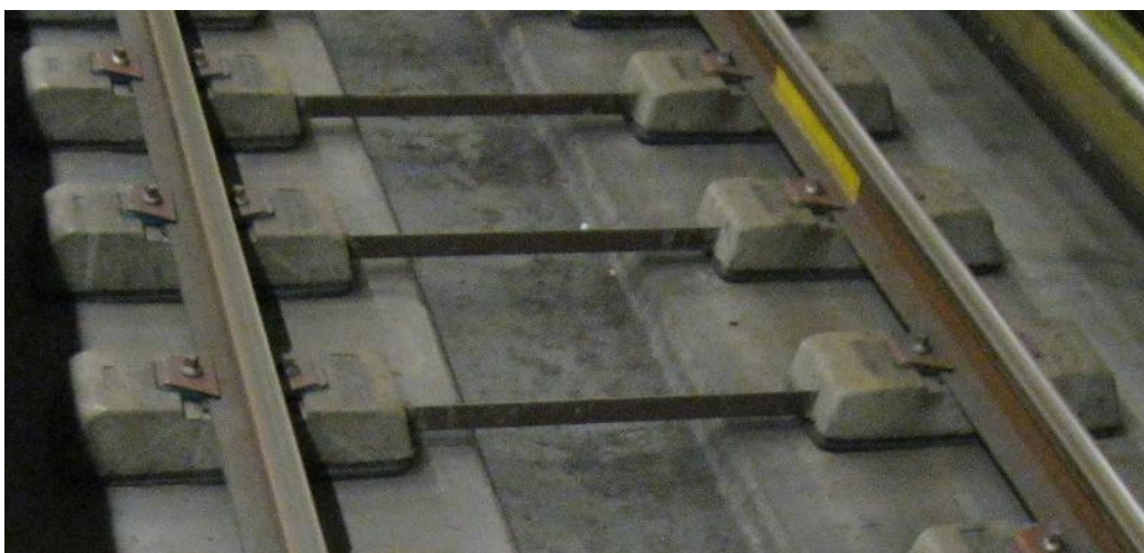
Εικόνα 2.3 : Διμερείς στρωτήρες από σκυρόδεμα στο Αττικό Μετρό
