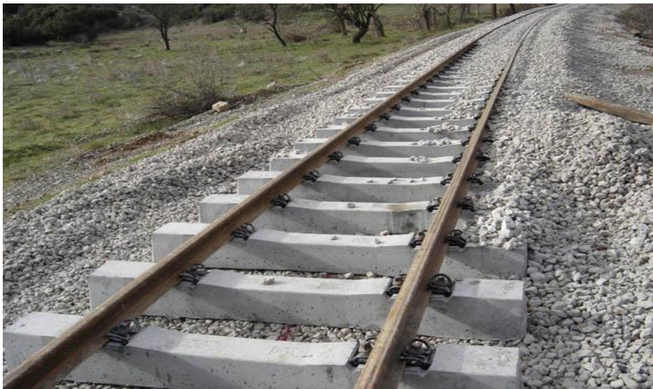
Εικόνα 2.2 : Ολόσωμοι στρωτήρες από σκυρόδεμα (B70) σε σκυρογραμμή
