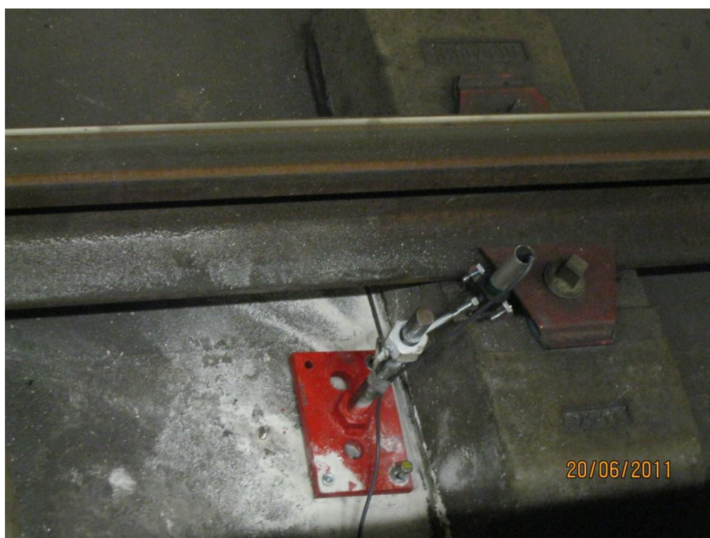
Εικόνα 4.13: Τοποθέτηση μηχανοσυστοιχίας (τελικές μετρήσεις στο Σύστημα)
