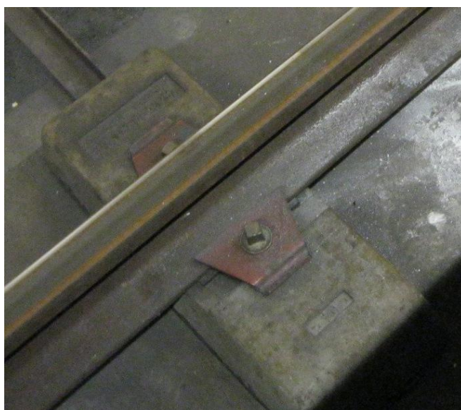
Εικόνα 2.4 : Σύνδεσμος Nabla
