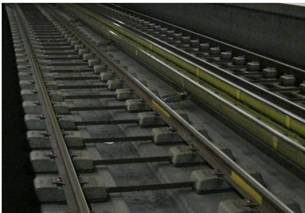
Εικόνα 1.4 : Σταθερή επιδομή στο Αττικό Μετρό
