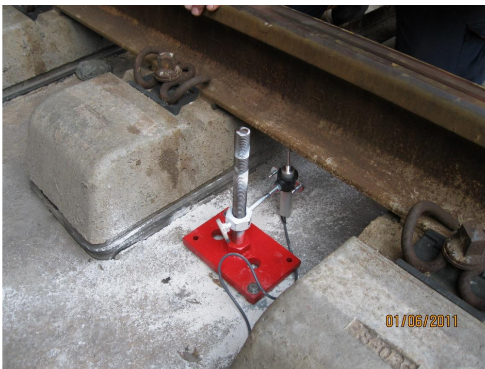
Εικόνα 4.12: Τοποθέτηση μηχανοσυστοιχίας 2 (δοκιμαστικές μετρήσεις)
