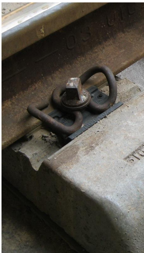
Εικόνα 2.5 : Σύνδεσμος Skl
