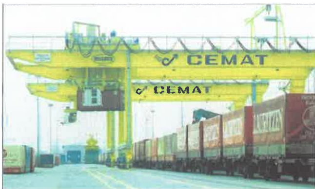
Σχήμα 3.3.11: Πλαισιωτή γερανογέφυρα επί σιδηροτροχιών Πηγή: (16)
