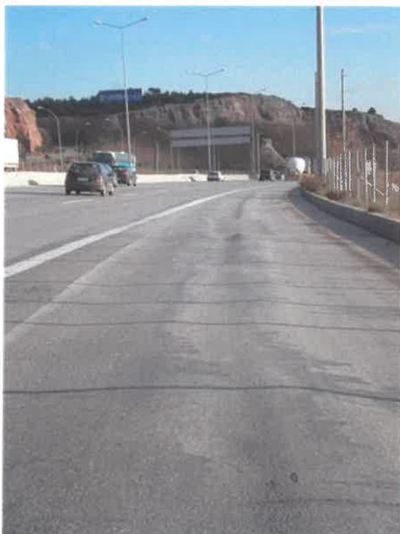
Σχήμα 2.1 : Τοπικές ανυψώσεις κατά μήκος εμφάνισης των τροχοαυλακώσεων
