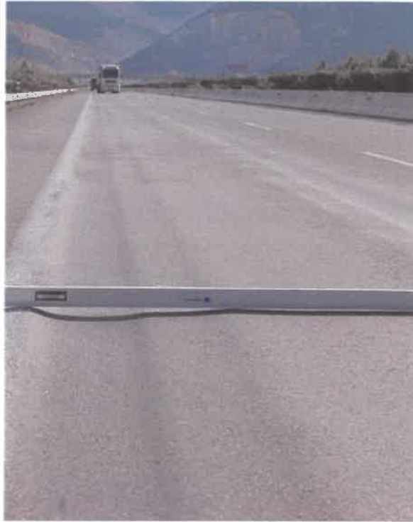
Σχήμα 2.2 : Εμφάνιση τροχοαυλακώσεων λόγω συμπίκνωσης των στρώσεων από την κυκλοφορία
