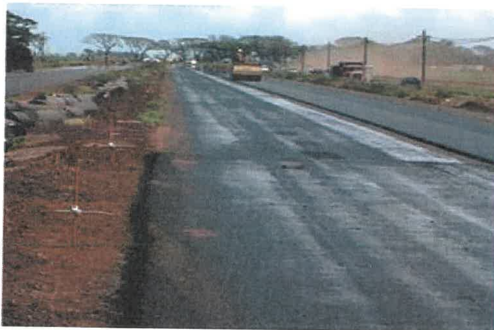
Εικόνα 1.3 Εφαρμογή της επιφανειακής ανακύκλωσης [22]
