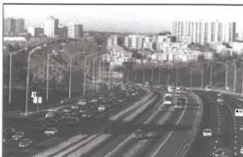
Σχήμα 4-3: Αυτοκινητόδρομος με κλάδους αντίστροφης ροής (reverse-flow)
