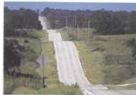
Σχήμα 2-4: Εικόνα χάραξης τύπου roller-coaster
