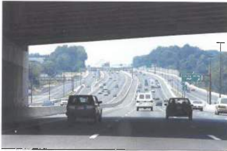
Σχήμα 4-4: Διπλά διαχωρισμένος αυτοκινητόδρομος (dual-divided) με δώδεκα λωρίδες
