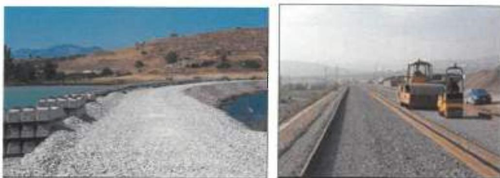
Εικόνα 10.3. Συμπύκνωση γραμμής με χρήση οδοστρωτήρα
