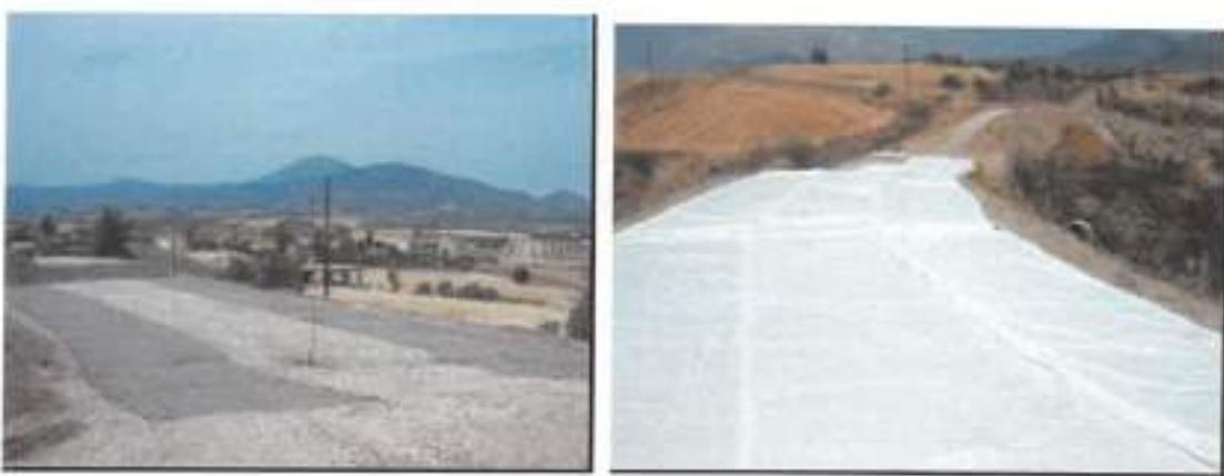
**Εικόνα 4.6 και 4.7.** Στρώση γεωπλέγματος και γεωυφάσματος
