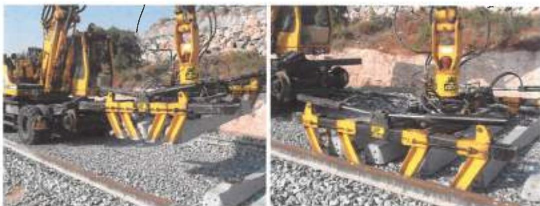
**Εικόνα 11.14 και 11.15.** Τοποθέτηση στρωτήρων επί του έρματος
