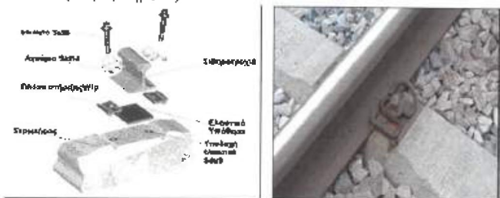
Εικόνα 4.4. Σύνδεση W14 επί στρωτήρων B70 με συνδέσμους Skl
