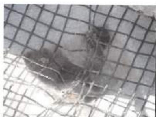
**Εικόνα 11.10 και 11.11.** Τρύπημα και φθορά του γεωυφύσματος και του γεωπλέγματος, μετά σπό τακτοποίηση των στρωτήρων
