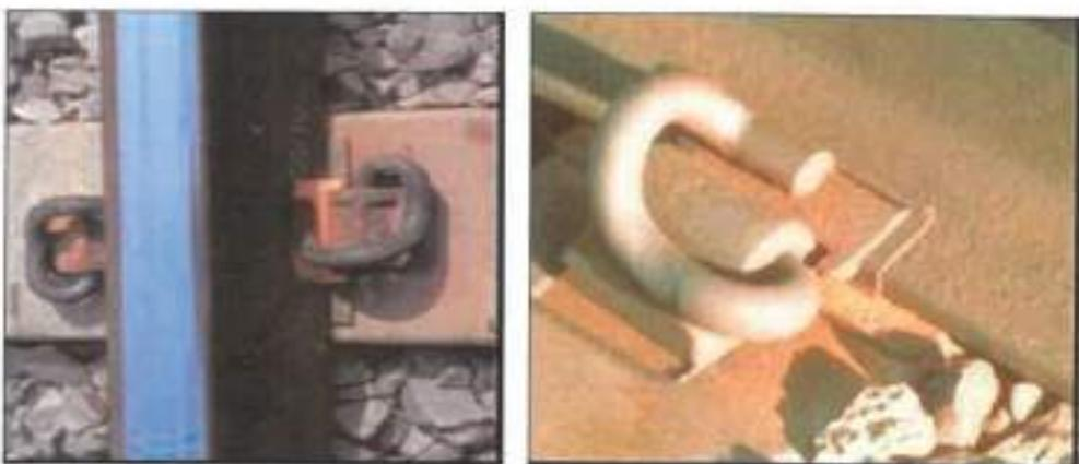
Εικόνα 4.8 και 4.9. Σύνδεση Pandrol επί μπετονένιων στρωτήρων
