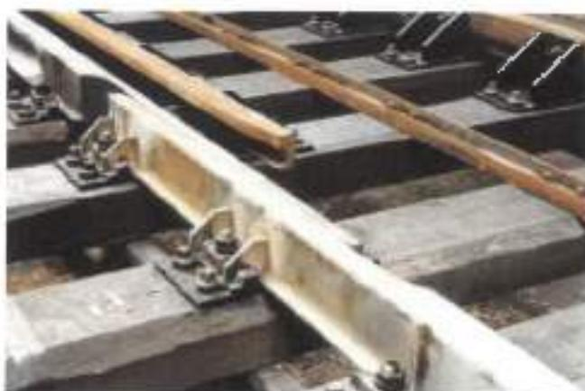
**Εικόνα 5.2.** Συσκευή διάστολής από μισές σιδηροτροχιές (γαλλικού τύπου)
