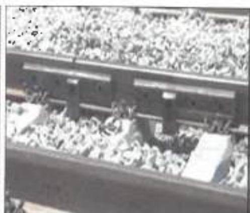
Εικόνα 4.20 και 4.21. Σύνδεση με μόνιμο (άριστερά) και με προσωρινό (δεξιά) αμφιδέτη
