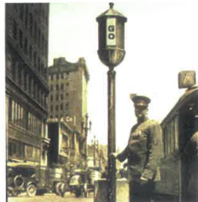
Στα αριστερά, το τεσσάρων κατευθύνσεων και τριών χρωμάτων φανάρι του Potts. Δεξιά, ένα παράδειγμα άλλου σηματοδότη της εποχής.
