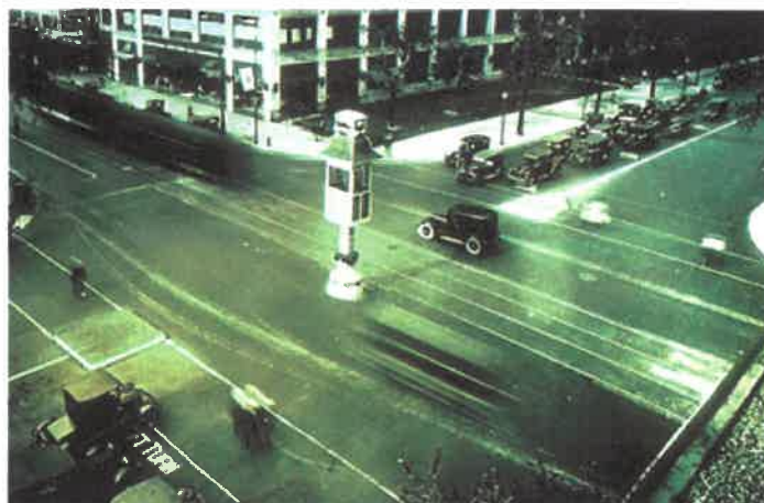
Πύργος σηματοδότησης στο Ντιτρόιτ, Μίσιγκαν.
