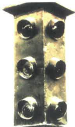
Στα αριστερά, το τεσσάρων κατευθύνσεων και τριών χρωμάτων φανάρι του Potts. Δεξιά, ένα παράδειγμα άλλου σηματοδότη της εποχής.
