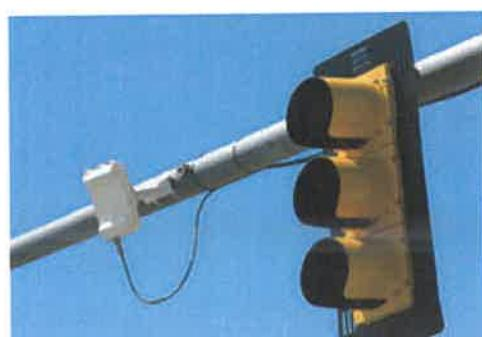
**Σχ.1.54:** Ραντάρ μικροκυμάτων εγκατεστημένο σε στύλο σηματοδότησης πάνω από την οδό.(ΠΗΓΗ: [www.wavtronix.com](http://www.wavtronix.com))
