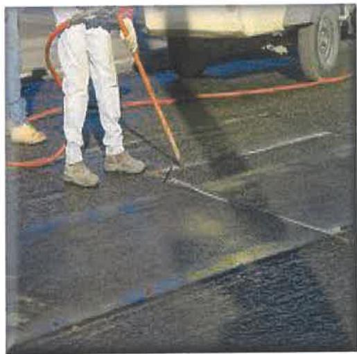
**Σχ.1.34:** Καθαρισμός, σε δεύτερη φάση, της εγκοπής με πεπιεσμένο αέρα για την απομάκρυνση φερτών υλικών και του νερού που χρησιμοποιήθηκε πριν. (ΠΗΓΗ: [www.renoae.com](http://www.renoae.com))
