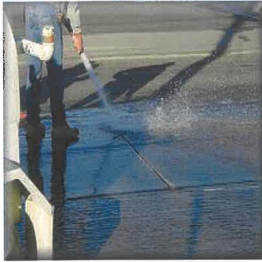
**Σχ.1.33:** Καθαρισμός, σε πρώτη φάση, με νερό υψηλής πίεσης της εγκοπής στο οδόστρωμα για απομάκρυνση των ανεπιθύμητων φερτών υλικών. (ΠΗΓΗ: [www.renoae.com](http://www.renoae.com))
