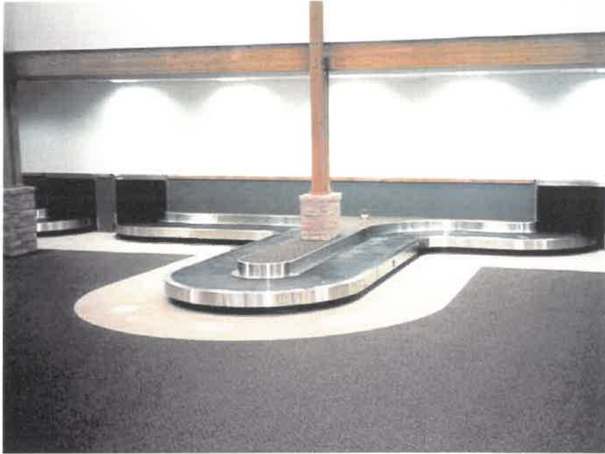
Εικόνα 3.5.1 Ατέρμων πελματική ταινία με μηνίσκους [Πηγή: 5]
