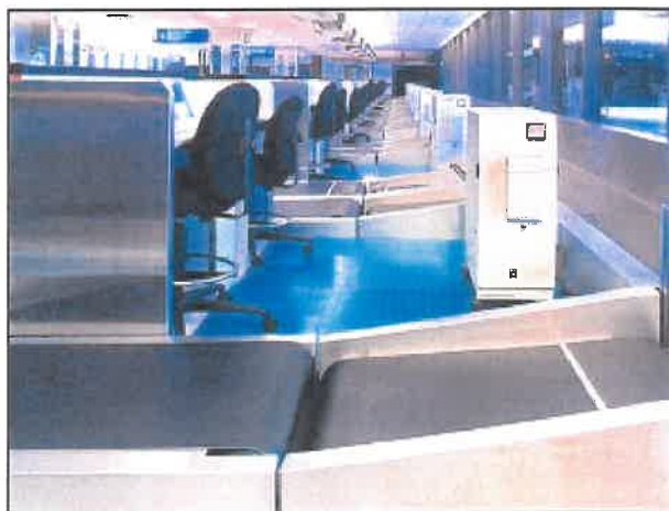
Εικόνα 3.3.1 Μεταφορικές ταινίες στα σημεία ελέγχου εισιτηρίων [Πηγή: 12]
