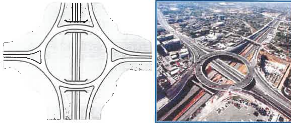
Σχήμα 2.8: Κυκλικός κόμβος δυο γεφυρών. [5]
