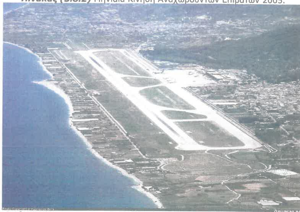
Εικόνα (5.8.2) Αεροφωτογραφία του αερολιμένα της Κεφαλονιάς όπου διακρίνονται ο διάδρομος προσαπογειώσεων και τα δάπεδα στάθμευσης. (Πηγή: www.airliners.net )
