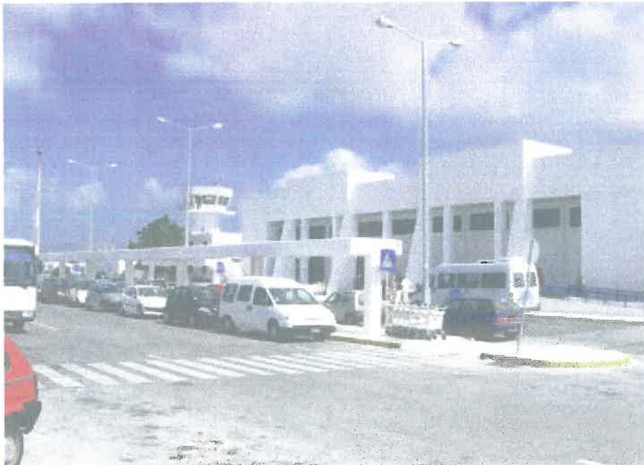
Εικόνα (5.9.1) Πλάγια όψη του κτηρίου επιβατών στο αεροδρόμιο της Μυκόνου.
