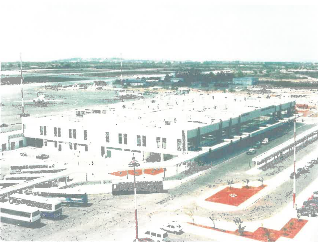
Εικόνα (5.4.1) Πανοραμική άποψη του αερολιμένα των Χανίων. (Πηγή: www.hcaa.gr )
