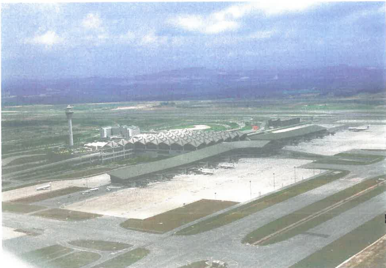
Εικόνα (1.8) Το αεροδρόμιο στην Kuala Lumpur της Μαλαισίας. Τα κτήρια του αεροσταθμού είναι κτισμένα στη μέση της ευρύτερης έκτασης του αερολιμένα και έχουν προβλήτες σχήματος «+» για τη στάθμευση των αεροσκαφών. (Πηγή: www. tropicalisland.de )
