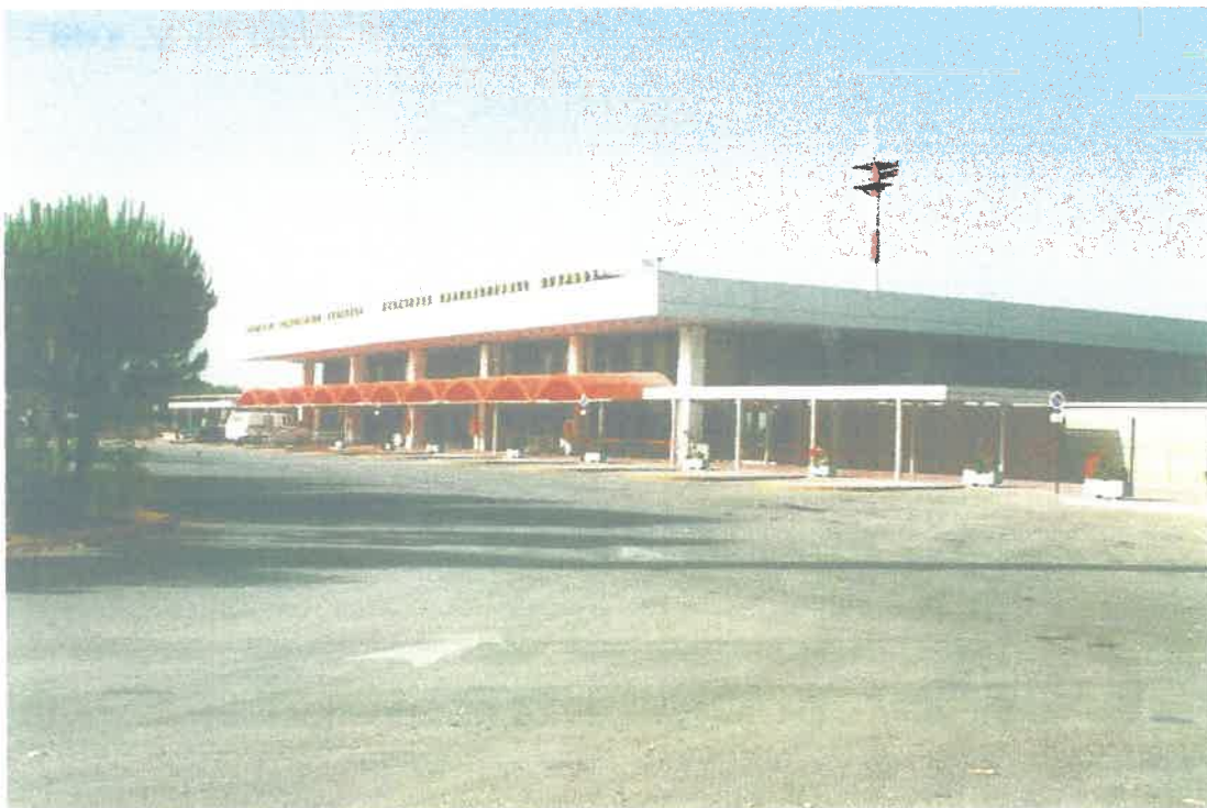
Εικόνα (5.5.1) Πλάγια όψη του κτηρίου επιβατών του αερολιμένα Ζακύνθου (Πηγή: www.hcaa.gr )
