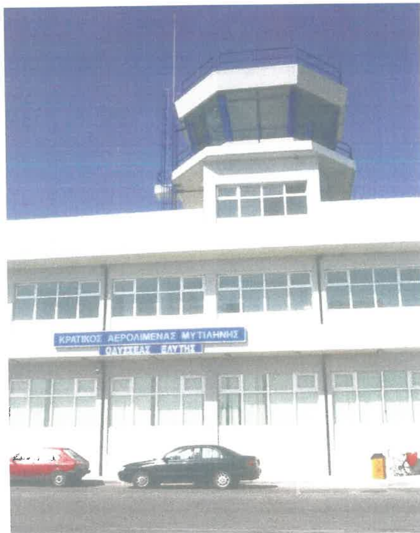
Εικόνα (5.7.1) Κύρια όψη του κτηρίου επιβατών του αερολιμένα Μυτιλήνης. (Πηγή: www.hcaa.gr )
