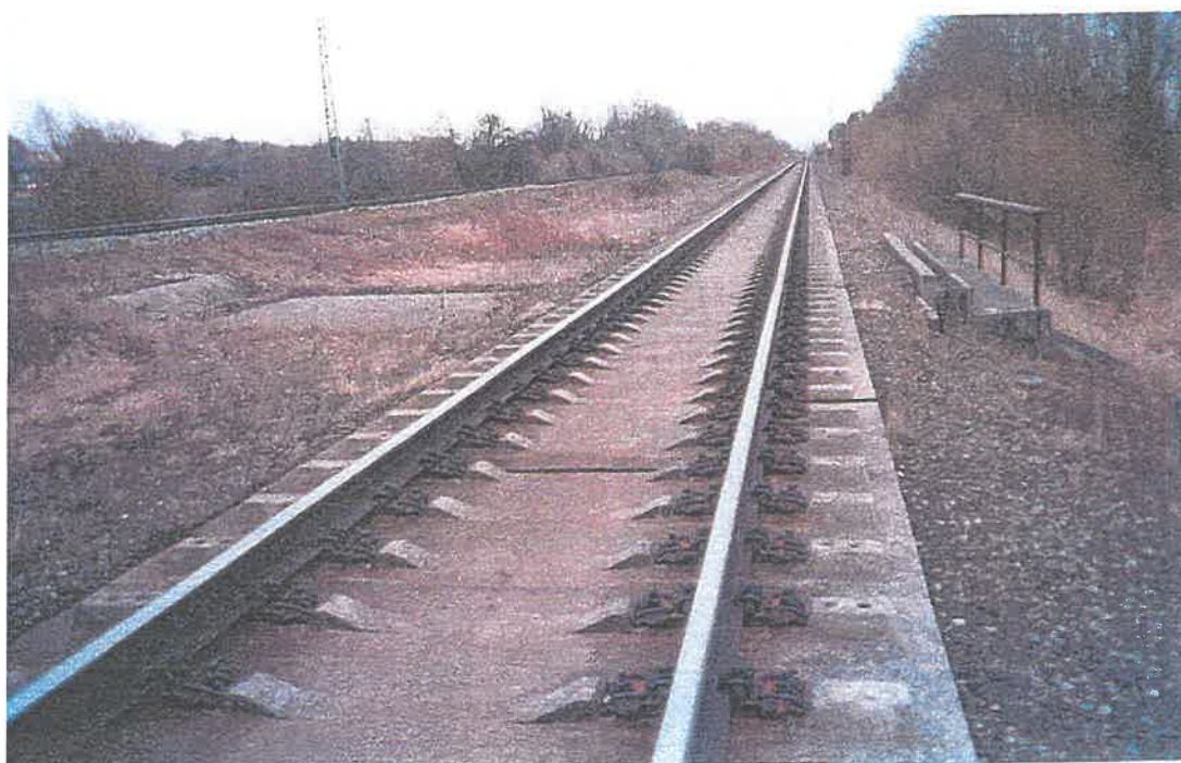
εικ.3 (Προκατασκευασμένες φέρουσες πλάκες σκυροδέματος με εγκάρσια προένταση , σε μήκος 430 m)
