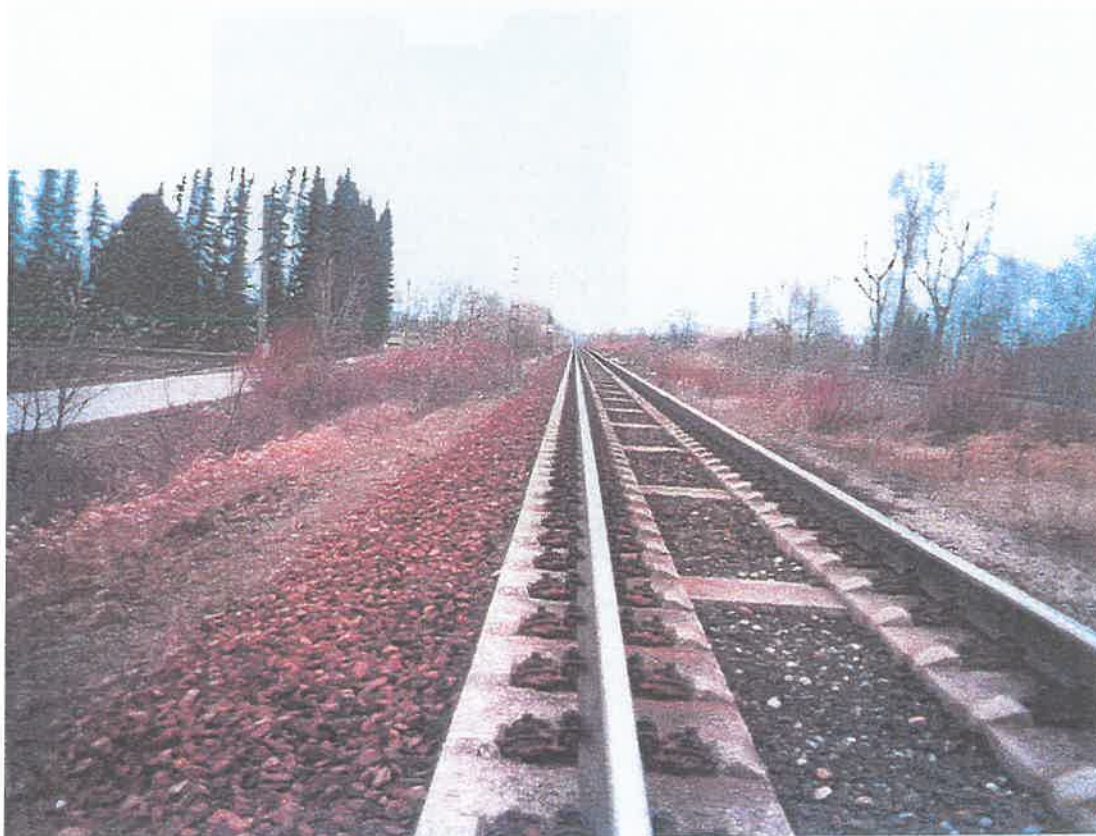
εικ. 4 Προκατασκευασμένα πλαίσια εκ σκυροδέματος
