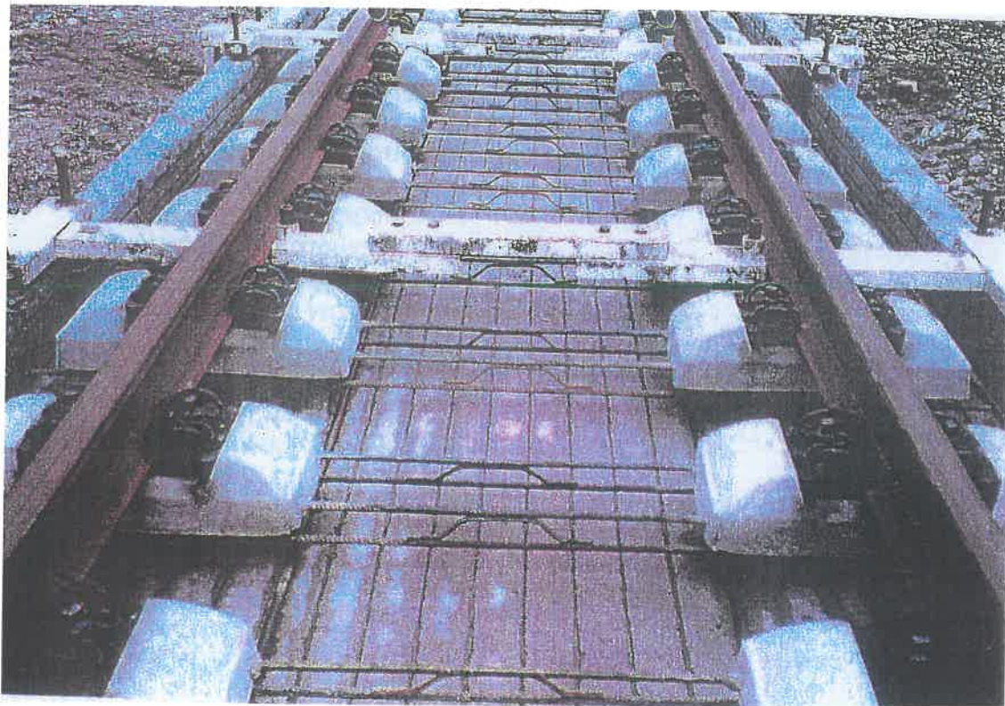
εικ. 12 Εσχάρα γραμμής σε σκυρογραμμή
