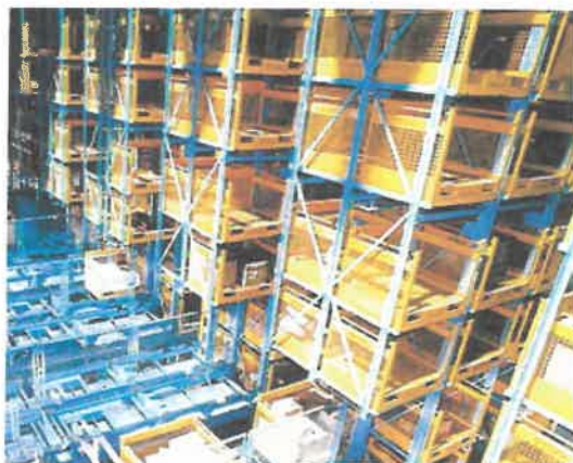
Εικόνα 2.36: Σύστημα πλαισίου ραφιών στον εμπορευματικό σταθμό του αεροδρομίου του Χονγκ Κονγκ [Πηγή:36]
