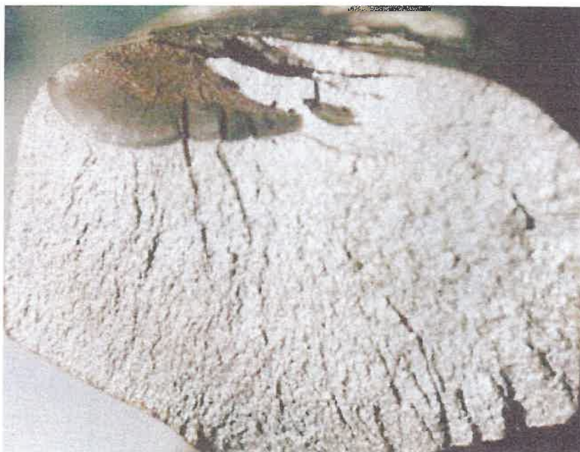
εικόνα4-3. Εγκάρσια ρωγμή και επακόλουθη αστοχία σιδηροτροχιάς που προέρχεται από αλλαγή κατεύθυνσης ρωγμής κεφαλής head check (Πηγή: Ringsberg J.W., Loo-Morrey M., Josefson B.L., 2000).
