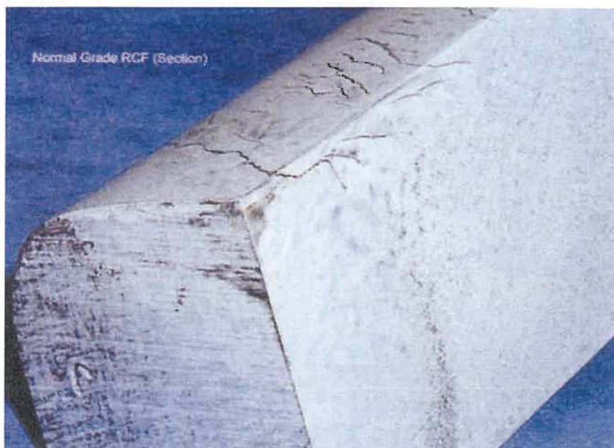
Εικόνα 4-2. Ανάπτυξη ρωγμών κεφαλής (head checks λόγω κόπωσης εξ επαφής). (Πηγή: Ringsberg J.W., Loo-Morrey M., Josefson B.L., 2000).
