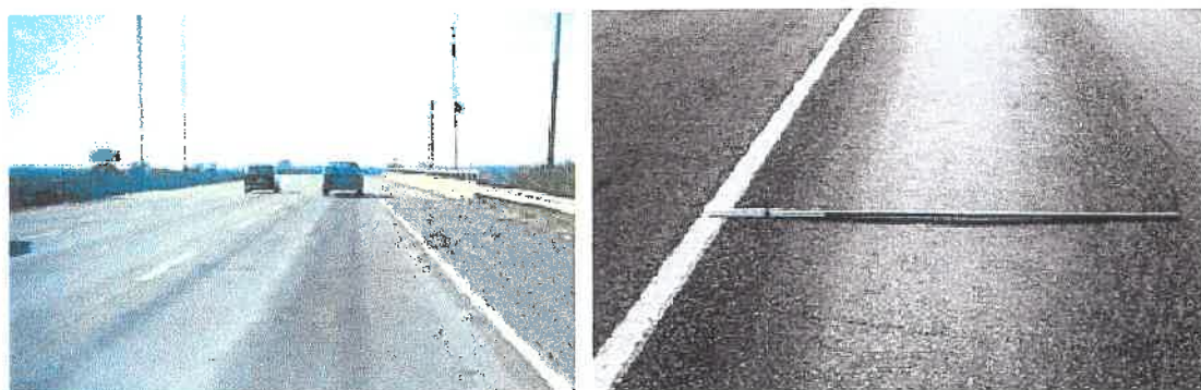
Σχήμα 2.4 Τροχοαυακώσεις στο οδόστρωμα.
