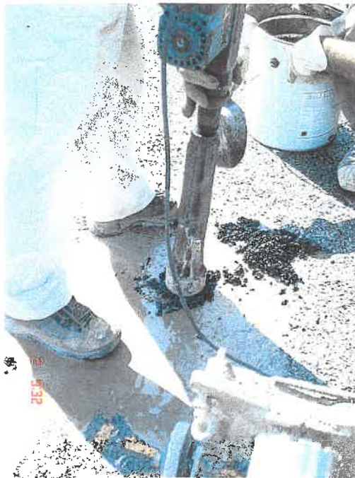
Σχήμα 5.4 Αποκατάσταση οπής.
