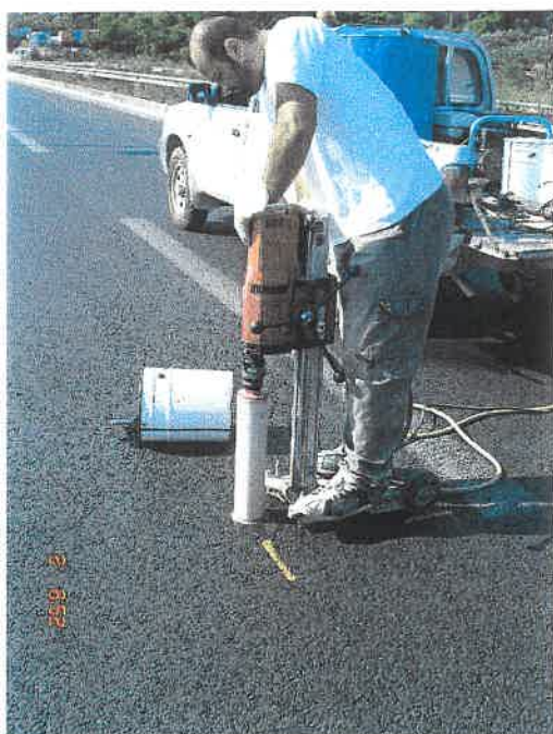
Σχήμα 5.1 Έναρξη κοπής πυρήνα.
