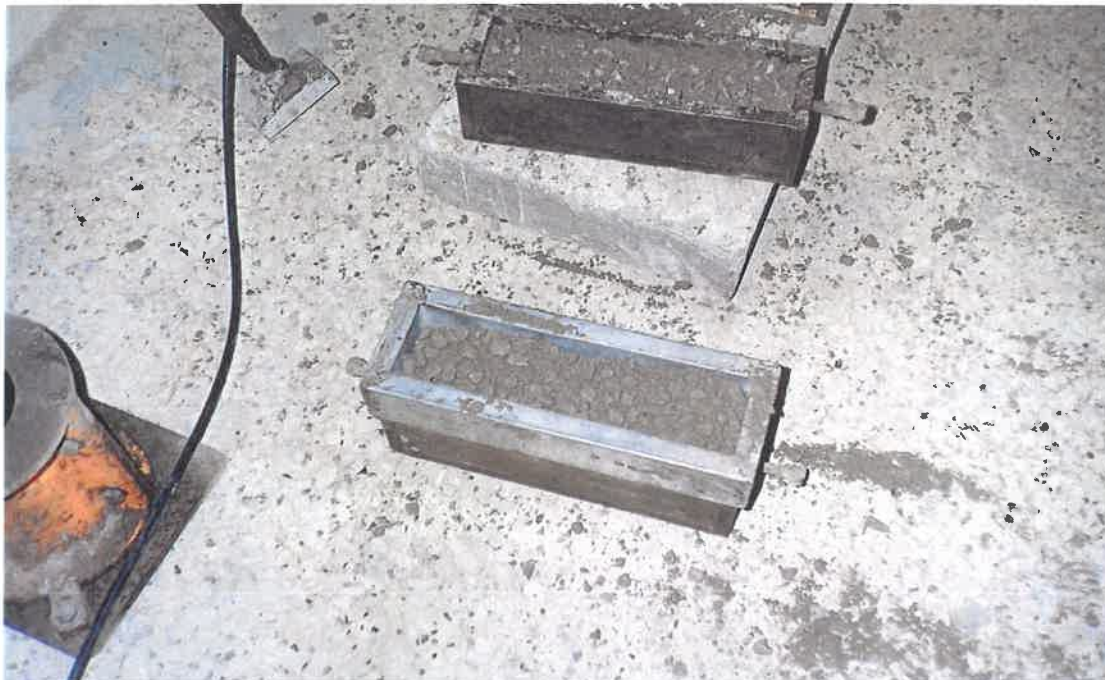
ΦΩΤΟΓΡΑΦΙΑ 4.3.7. ΣΥΜΠΥΚΝΩΣΗ ΤΗΣ ΔΕΥΤΕΡΗΣ ΣΤΡΩΣΗΣ ΜΕ ΤΗ ΧΡΗΣΗ ΚΑΛΟΥΠΙΟΥ – ΠΡΟΕΚΤΑΣΗΣ ΧΩΡΙΣ ΠΥΘΜΕΝΑ
