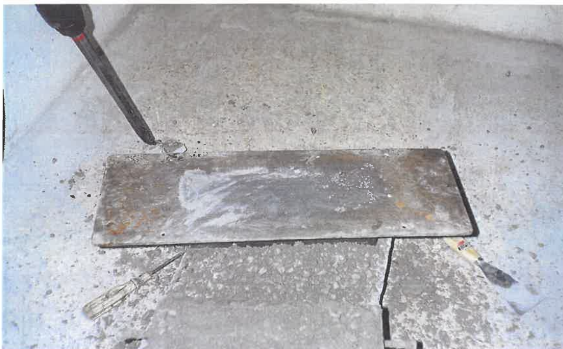
ΦΩΤΟΓΡΑΦΙΑ 4.3.8. ΜΟΡΦΩΣΗ ΤΕΛΙΚΗΣ ΕΠΙΦΑΝΕΙΑΣ ΜΕ ΧΡΗΣΗ ΜΕΤΑΛΛΙΚΗΣ ΠΛΑΚΑΣ
