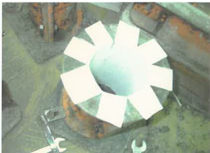
Φωτογραφία. 2: Κυλινδρικό καλούπι μετά την τοποθέτηση του πολυμερούς χαρτιού.
