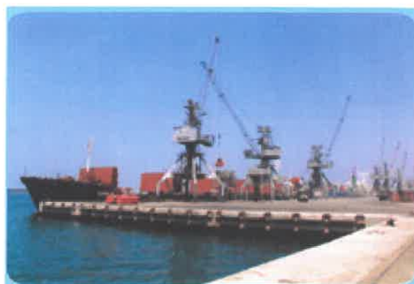
Σχήμα 5.2 : Λιμενική εγκατάσταση στον λιμένα Latakia. [Πηγή5]
