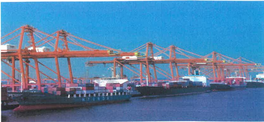
Εικόνα 1.1: Γερανογέφυρες προκυμαίας [Πηγή 17]
