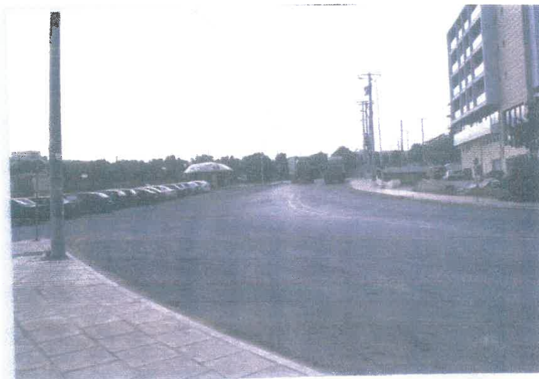
Φωτογραφία 2 : Κεντρική είσοδος / έξοδος στη λιμενική εγκατάσταση όπως φαίνεται μέσα από το λιμάνι.
