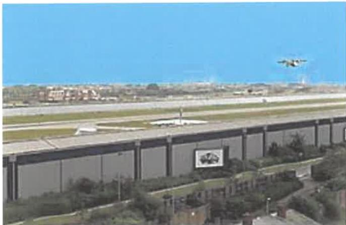
Εικόνα 5-5 – Χρήση της αποβάθρας επιβίβασης ως ηχοπέτασμα.
