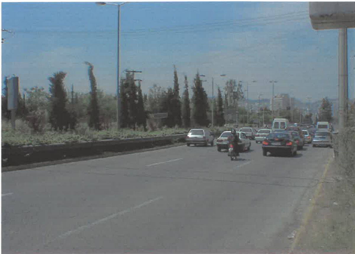
Εικόνα 3.4 : Θέση εγκατάστασης του φορατή ADR 4.
