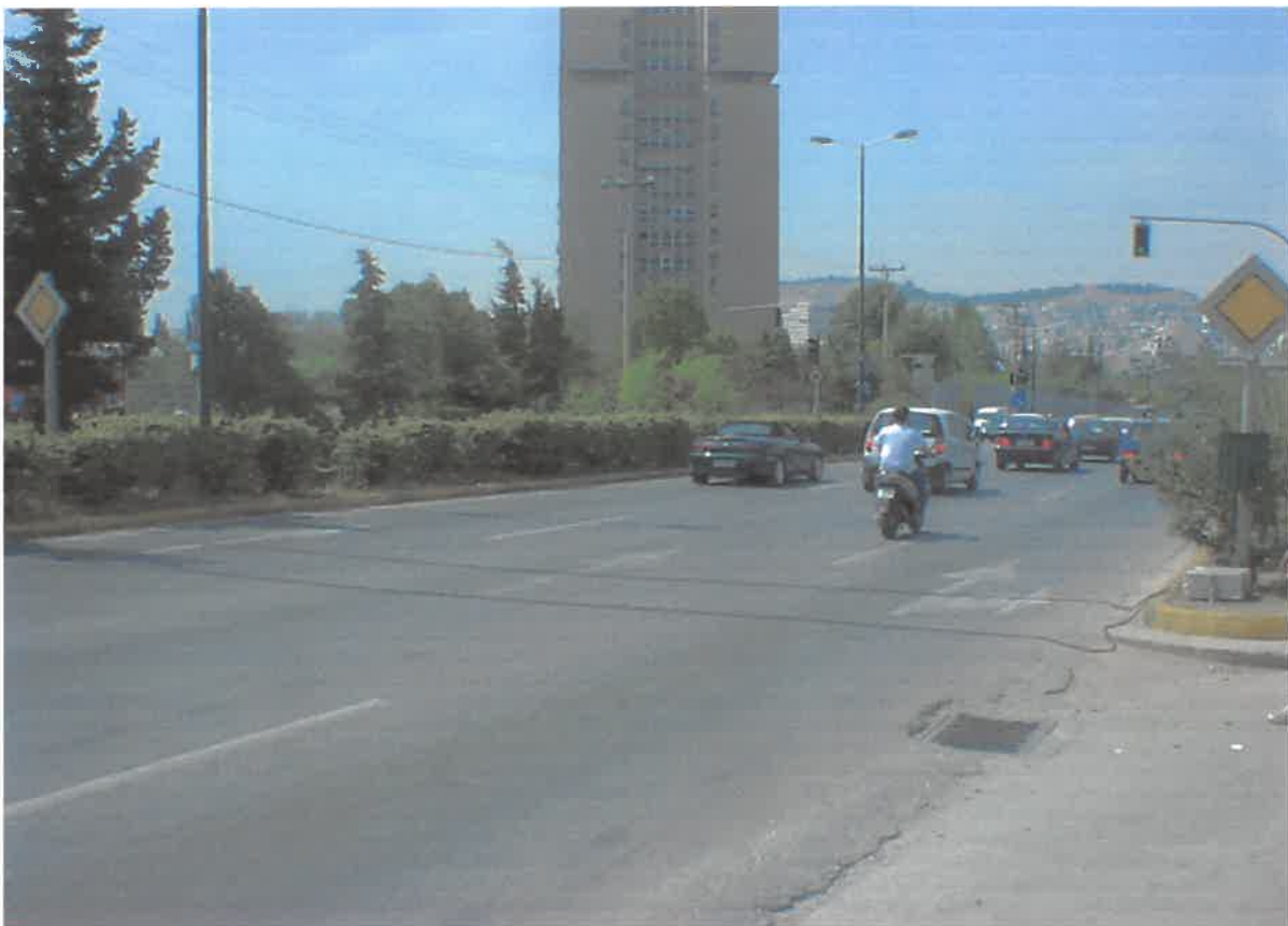
Εικόνα 3.2 : Θέση εγκατάστασης του φορατή ADR 2.
