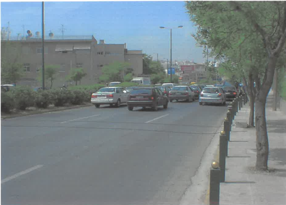
Εικόνα 3.1 : Θέση εγκατάστασης του φορατή ADR 1.
