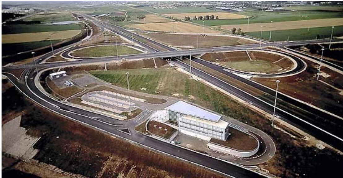
Φωτογραφία 1 : Ανισόπεδος κόμβος μορφής μερικού τετράφυλλου στο Ισραήλ. (πηγή : διαδίκτυο - www.worldnewsstand.net/03/SR/8-2.htm )
