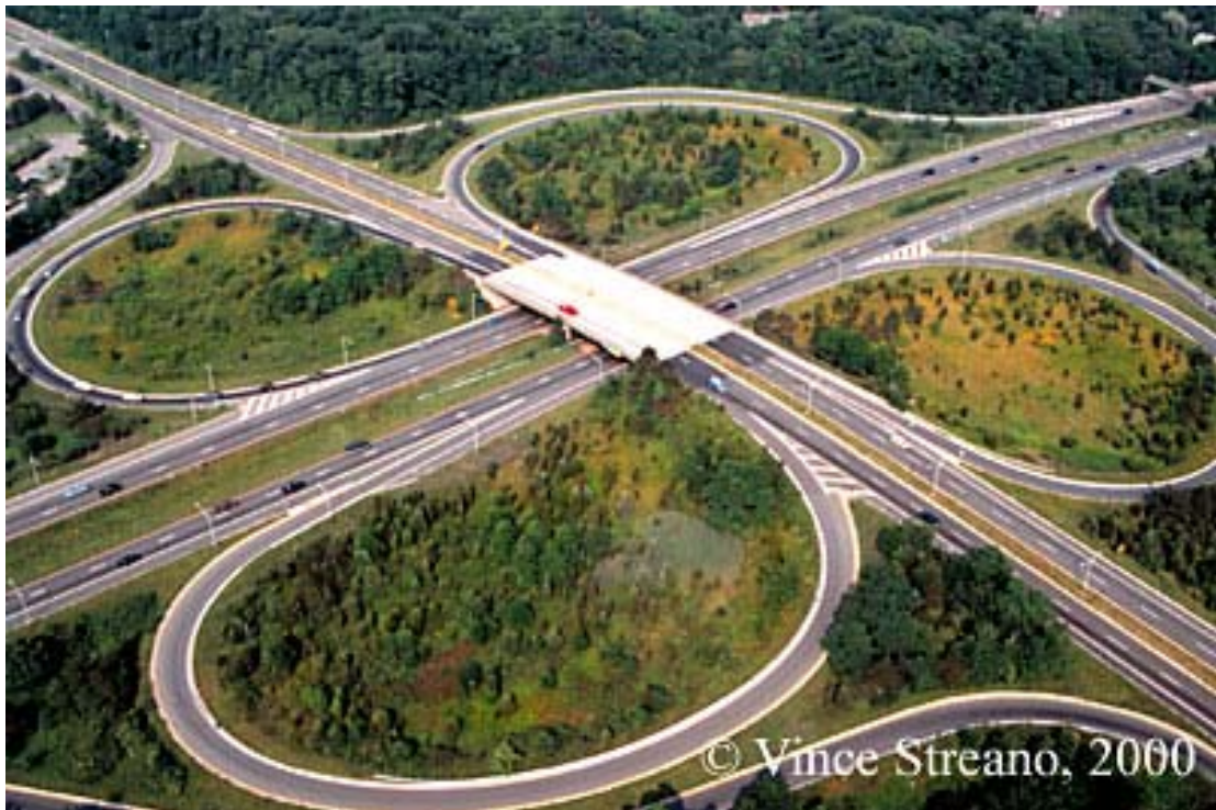
Φωτογραφία 2 : Ανισόπεδος κόμβος μορφής πλήρους τετράφυλλου στο New Jersey των Η.Π.Α. (πηγή : διαδίκτυο - www.streano-havens.com/Aerials/Aerial4.htm )
