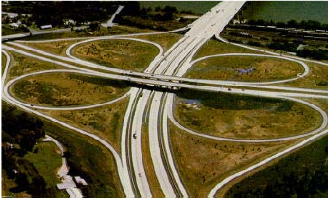
Φωτογραφία 5 : Υπό κατασκευή ανισόπεδος κόμβος μορφής πλήρους τετράφυλλου στην Πενσυλβάνια των Η.Π.Α. (πηγή : διαδίκτυο - www.photographerflanigan.com/aerial6.htm )
