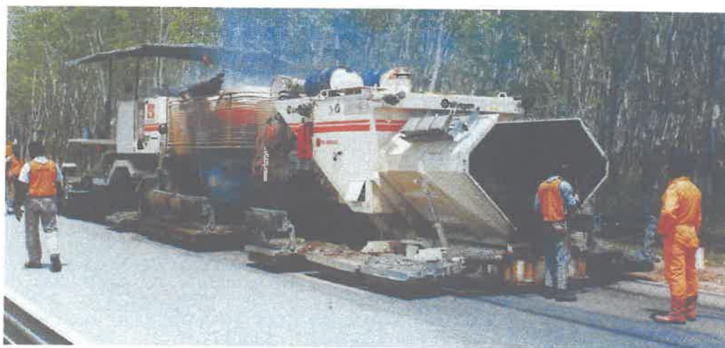
Εικόνα 1.8.1: Σύστημα ανακύκλωσης οδοστρωμάτων [4]
