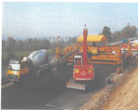
Εικόνες 1.8.6 - 1.8.7: Αυτοματοποιημένες διατάξεις ανακύκλωσης δύσκαμπτων οδοστρωμάτων [4]
