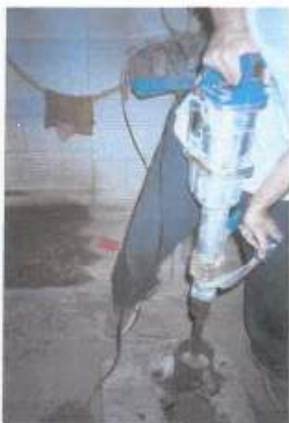
Φωτογραφία 5.6.6: Συμπύκνωση πρώτης στρώσης
