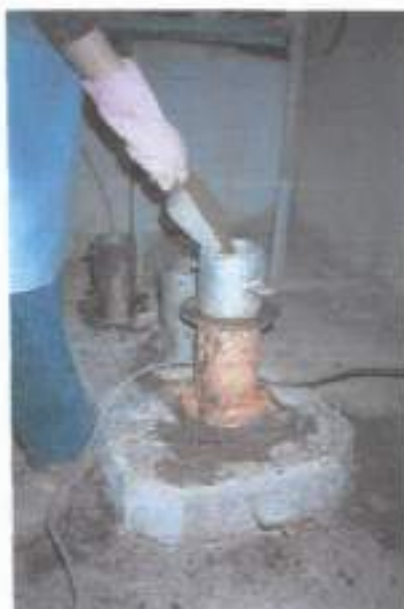
Φωτογραφία 5.6.7: Ρίψη υλικού δεύτερης στρώσης
