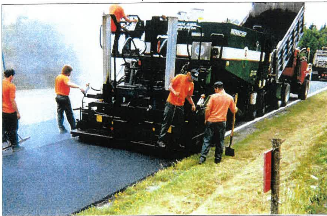
Εικόνα 2.3 Αυτοκινούμενο μηχάνημα παραγωγής και διάστρωσης ψυχρών ασφαλτομιγμάτων
