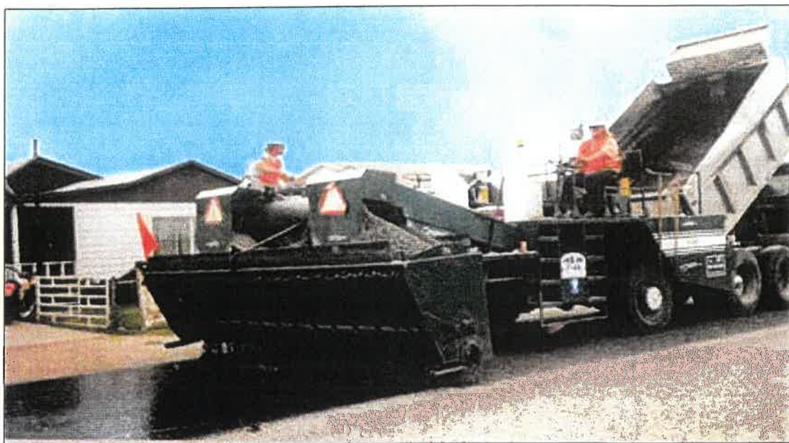
Εικόνα 2.7 Μηχάνημα παραγωγής και διάστρωσης μιγμάτων slurry
