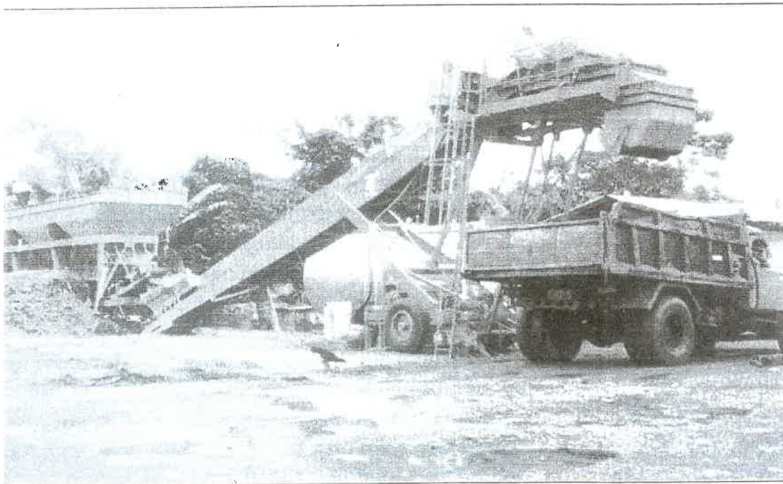
Εικόνα 2.2 Συγκρότημα παραγωγής ψυχρών ασφαλτομιγμάτων σε μόνιμη εγκατάσταση
