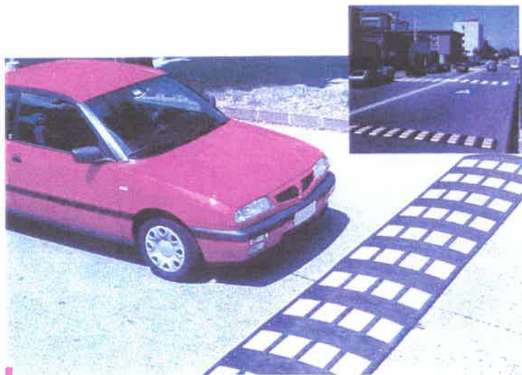
Εικόνα 4.3 Εγκάρσια υπερυψωμένη λωρίδα κυκλικού τύπου (σαμαράκι)
