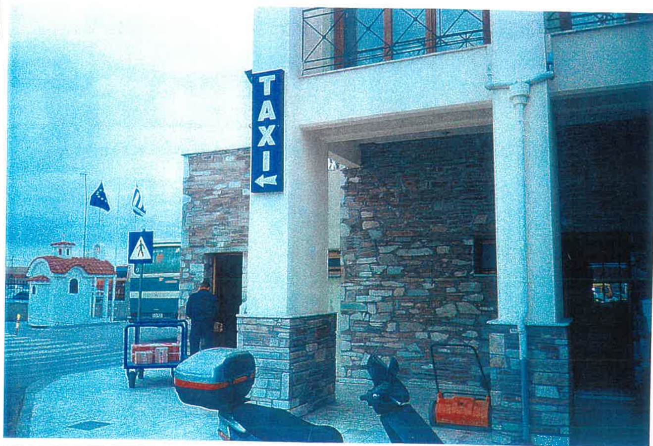
Σχ. 4.13: Σήμανση πληροφόρησης του χώρου του σταθμού TAXI
