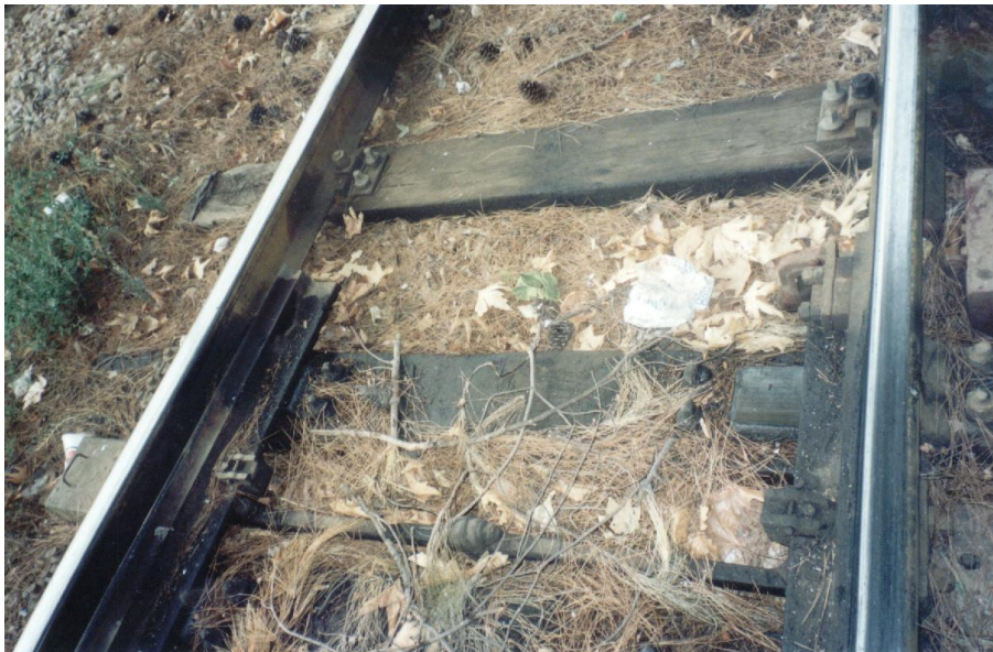
Εικόνα 9 : Σημείο επαφής καμπύλης βελόνας με την κύρια γραμμή, όπου και μετράται η απόσταση των 3mm.
