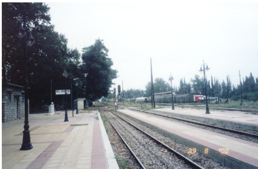
Εικόνα 4 : Συνολική όψη σηματοδότησης στην έξοδο του σταθμού Λιανοκλαδίου
