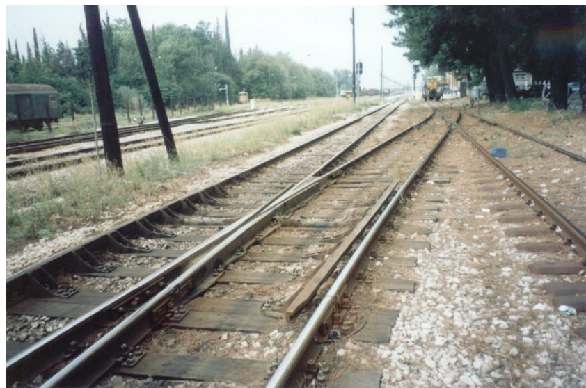
Εικόνα 8 : Απλή ευθύγραμμη αλλαγή, που οδηγεί το συρμό, στην παρεκκλίνουσα γραμμή.
