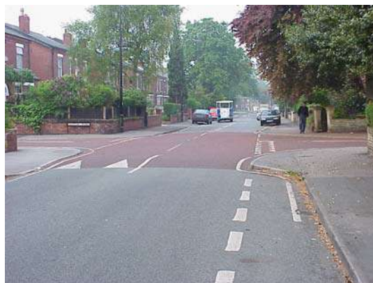
Εικόνα 2.6: Υπερυψωμένο οδόστρωμα σε διασταύρωση οδών (Πηγή: Ciekot, 2000)
