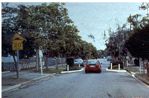
Εικόνα 2.8: Επέκταση πεζοδρομίου (Πηγή: Portland City, 2001)
