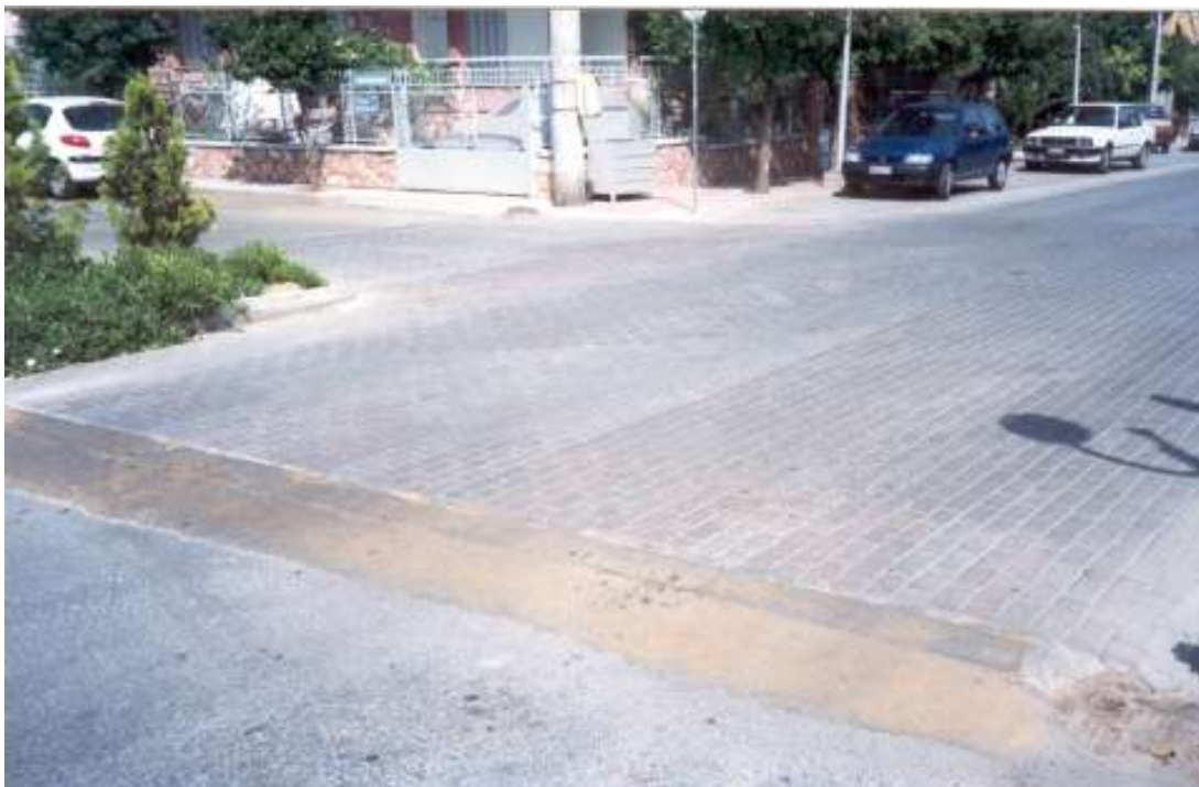
Εικόνα 5.4: Υπερυψωμένο οδόστρωμα οδού σε διασταύρωση στο Νέο Ψυχικό (Πηγή: προσωπικό αρχείο)
