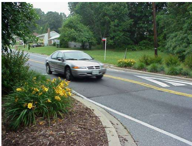
Εικόνα 2.1: Τοπική υπερύψωση (σαμαράκι) οδού (Πηγή Ciekoť, 2000 )
