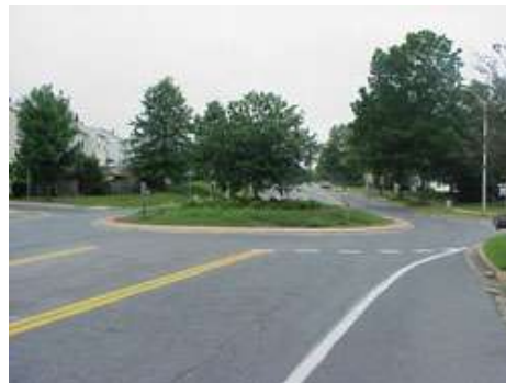
Εικόνα 2.4 Κυκλικός κόμβος σε συμβολή οδών (Πηγή Ciekot, 2000)
