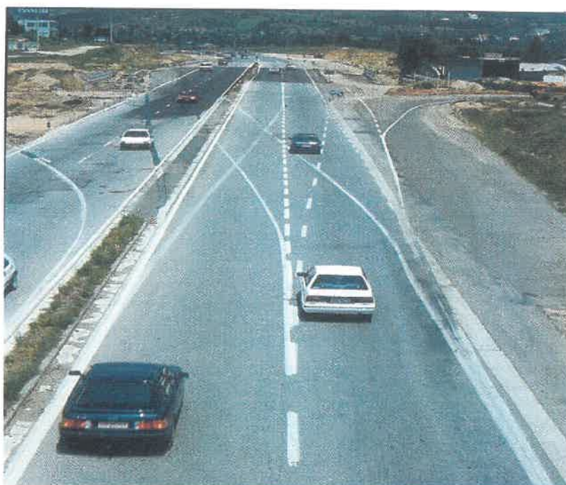
Σχήμα 5-2 Αποπροσανατολιστική σήμανση με είσοδο στο αντίθετο ρεύμα. Εθνική Οδός Αθηνών - Λαμίας, Καπανδρίτι Αττικής [35]
