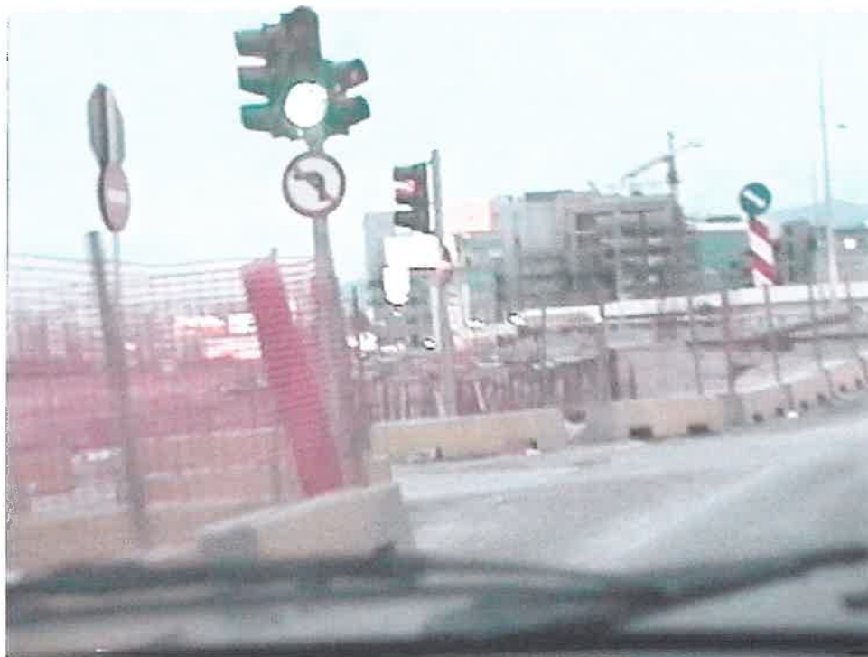
Σχήμα 5 –3 Υποτυπώδη “στηθαία” και πλαστικό πλέγμα για την οριοθέτηση. Λεωφόρος Κηφισίας 2001
