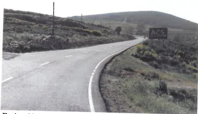
Εικόνα 11.44: Ανακυκλωμένο με τσιμέντο οδόστρωμα (ενός χρόνου)
