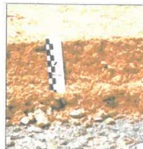
Εικόνα 6.1. Κοκκώδες υλικό που διαστρώνεται πάνω στην επιφάνεια του υπάρχοντος οδοστρώματος για τη συμπλήρωση του απαιτούμενου πάχους ανακύκλωσης. Άποψη γενική και λεπτομέρεια. .
