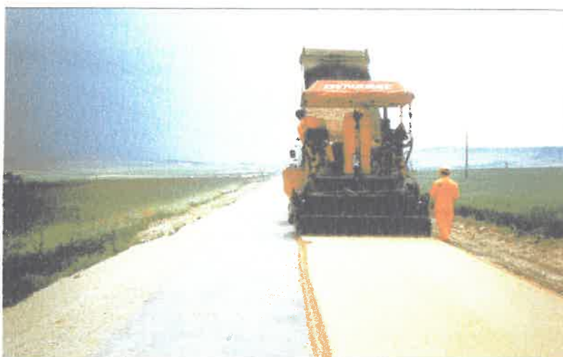
Εικόνα 6.1. Κοκκώδες υλικό που διαστρώνεται πάνω στην επιφάνεια του υπάρχοντος οδοστρώματος για τη συμπλήρωση του απαιτούμενου πάχους ανακύκλωσης. Άποψη γενική και λεπτομέρεια. .
