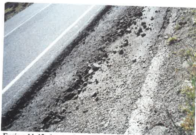
Εικόνα 11.45: Διαφορά μεταξύ παλιού και νέου (ενός έτους) ανακυκλωμένου οδοστρώματος
