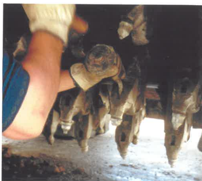
Εικόνα 11.32: Αντικατάσταση των δοντιών εκσαφής του τυμπάνου του ανακυκλωτήρα
