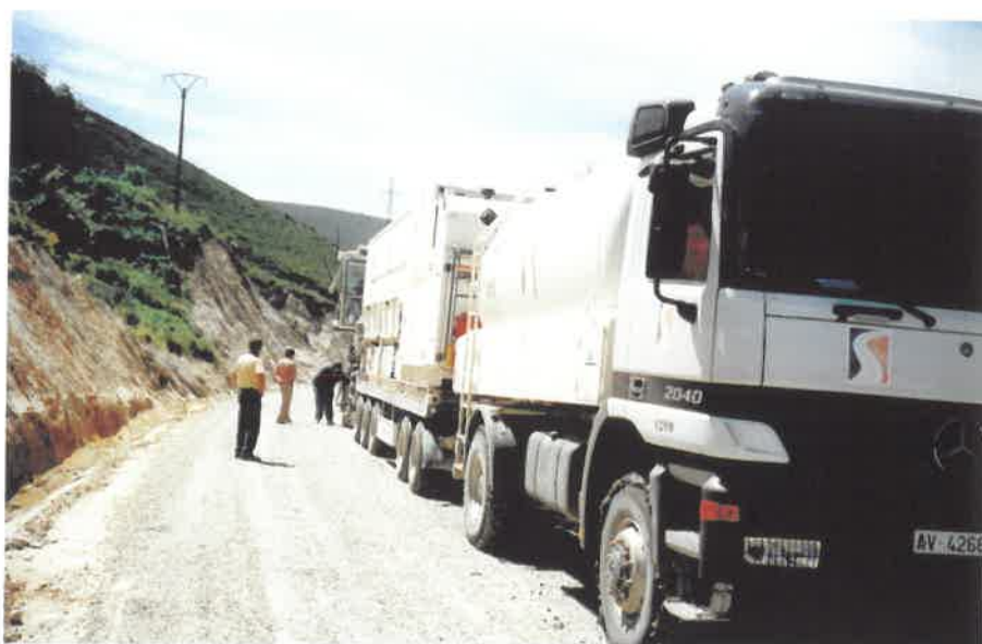
Εικόνα 11.18: Εφοδιασμός νερού (χωρίς διακοπή της εκτέλεσης του έργου)
