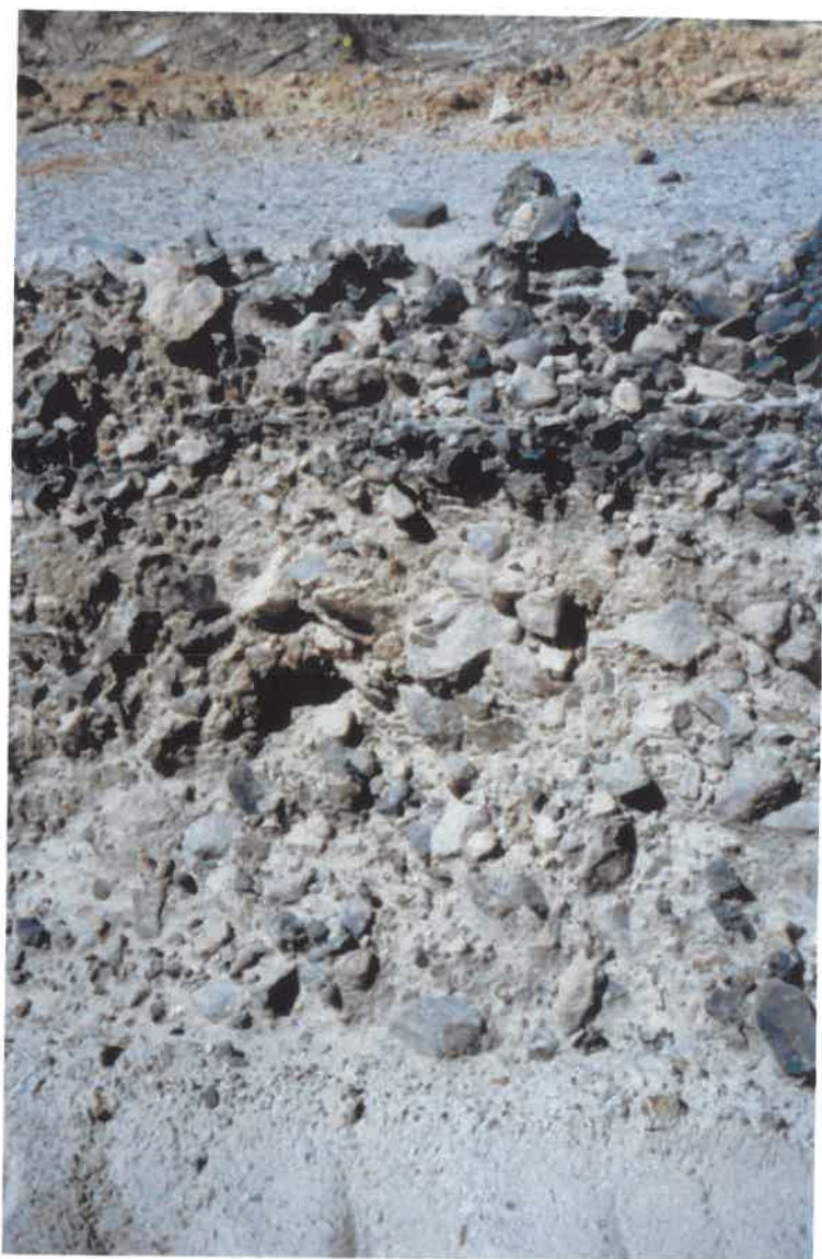
Εικόνα 11.7: Διατομή του παλιού, προς ανακύκλωση οδοστρώματος. Στρώση σκυρωτή, αργίλου και ασφαλτομίγματος (από κάτω προς τα πάνω)
