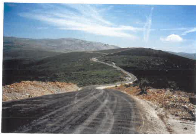
Εικόνα 11.37: Τελική όψη του ανακυκλωμένου οδοστρώματος
