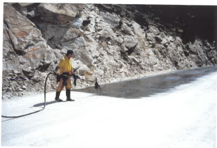
Εικόνα 11.36: Επάλειψη του ανακυκλωμένου οδοστρώματος με γαλάκτωμα συντήρησης
