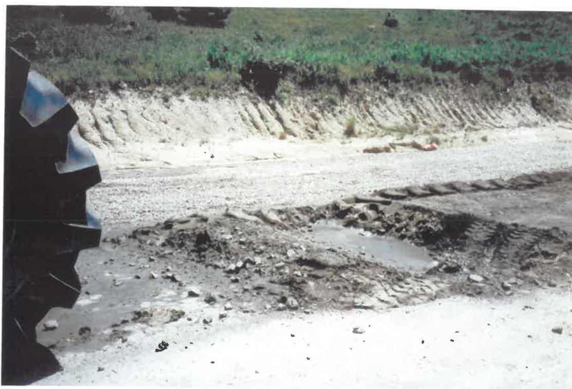
Εικόνα 11.31: Στάση του ανακυκλωτήρα με αποτέλεσμα τη δημιουργία λακκούβας στο σημείο αυτό
