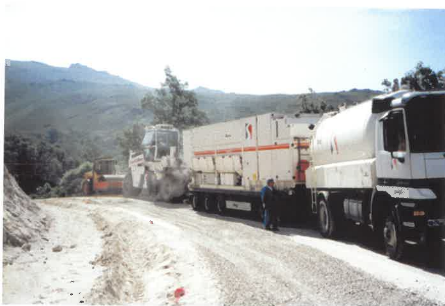
Εικόνες 11.4 και 11.5: Διάστρωση θραυστού υλικού κατά μήκος της διαπλάτυνσης της παλιάς οδού
