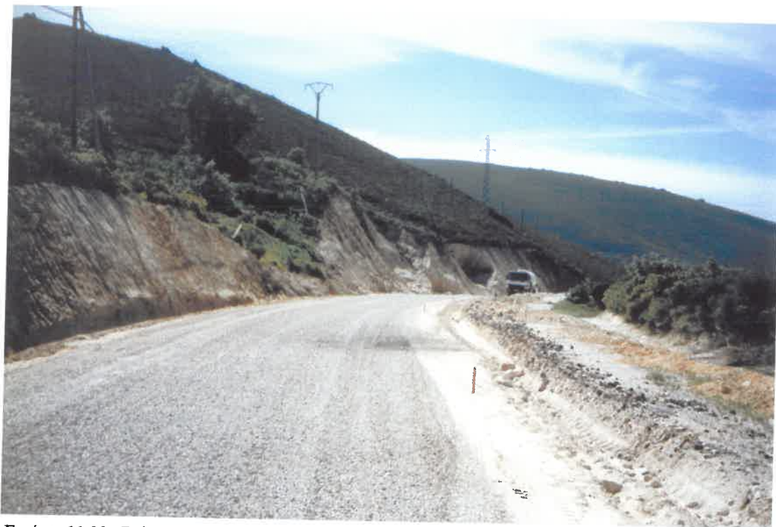
Εικόνα 11.33: Βελτίωση της οριζοντιογραφίας. Κατασκευή νέου δρόμου μέσω της τεχνικής της ανακύκλωσης. Έχει διαστρωθεί επιπλέον θραυστό υλικό στην επιφάνεια, προκειμένου να διορθωθεί η κοκκομετρική σύνθεση του προς ανακύκλωση υλικού. Οι κόκκινοι πάσσαλοι που φαίνονται στις άκρες του δρόμου ορίζουν τα σημεία από τα οποία θα πρέπει να περάσει ο ισοπεδωτήρας.
