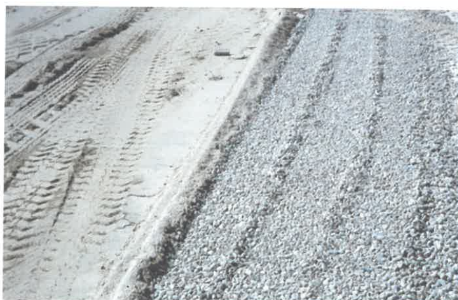
Εικόνα 11.6: Λεπτομέρεια της διάστρωσης επιπλέον αδρανών στη λωρίδα διαπλάτυνσης της παλιάς οδού
