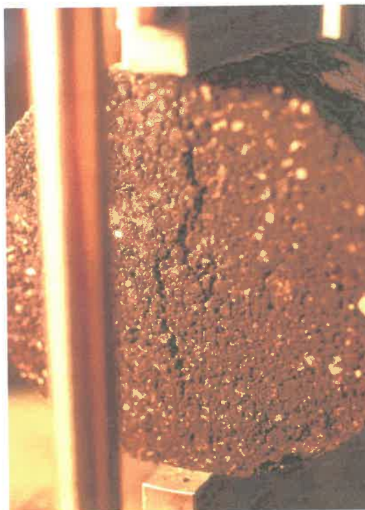
Εικόνα 2.4-10 Δημιουργία ρωγμής κατά την επιβολή του φορτίου
