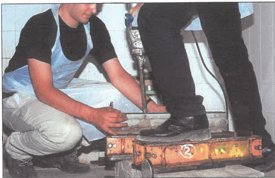
Εικόνα 2.3-8 Συμπύκνωση με ηλεκτρόσφυρα
