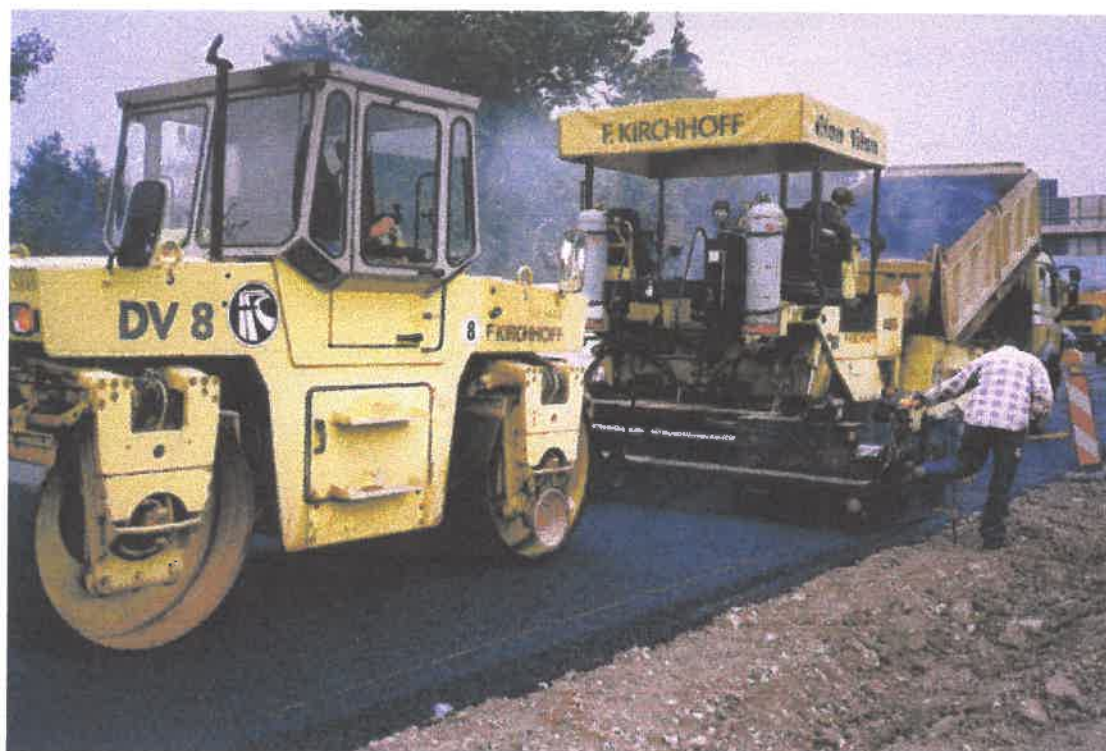
Σχήμα 4.1 Διάστρωση και συμπίκνωση SMA
